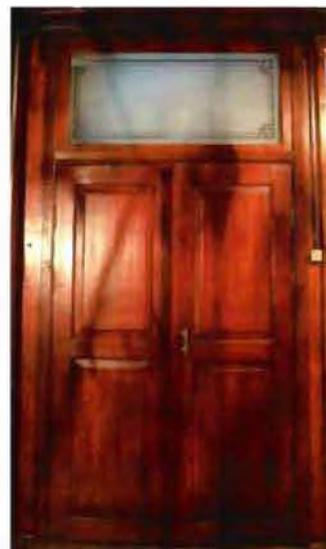
заполнение дверного проема тамбура – материал (дерево), конструкция (глухое, двустворчатое), оформление (дверное полотно на две филенки), дверные ручки, одна пара (материал – металл, тип «скоба»);
