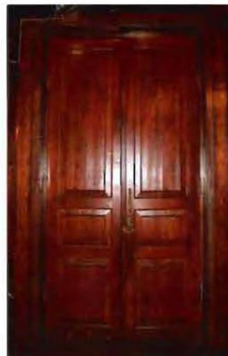
заполнение дверного проема в помещение 1-Н (23) – материал (дерево), конструкция (глухое, двустворчатое), оформление (дверное полотно на три филенки), дверные ручки, 1 пара (материал – металл, тип «скоба»);
