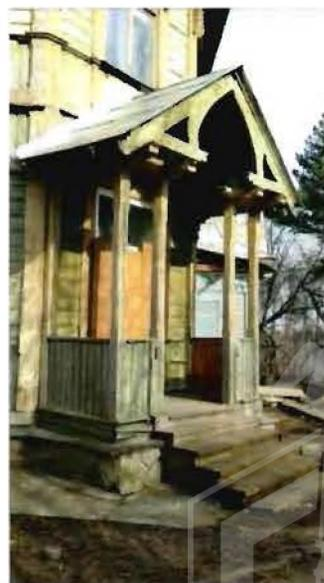
двухскатными козырьками на стойках, со стропильными конструкциями сложной формы с кобылками, завершенными волнитообразными элементами, опирающимися на балки с резными завершениями;
