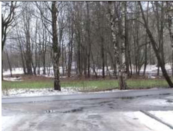
Фото 7 Состояние подъездных путей
