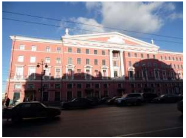
Фото 4 Ближайшее окружение, дом № 68а по Невскому. пр.
