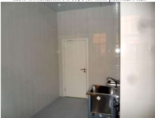
Фото 81 Часть помещения № 53, дверь в ч.п. № 38
