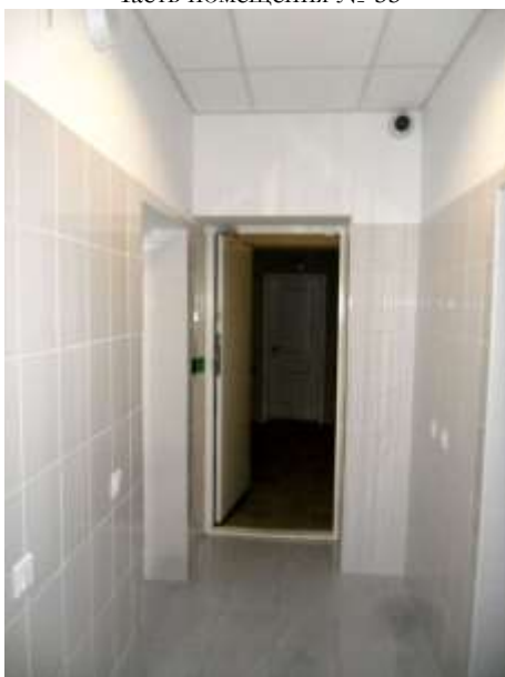
Фото 61 Часть помещения № 38. Вход в объект оценки из ч.п. № 34
