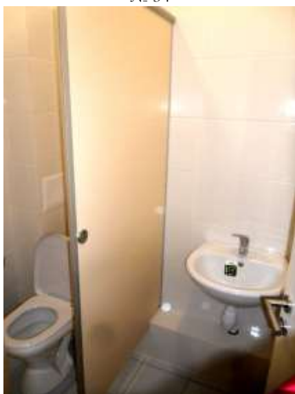
Фото 63 Часть помещения № 40, санузел
