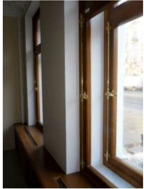
Фото 22 Окна в ч.п. № 70, выходящие на Невский пр.
