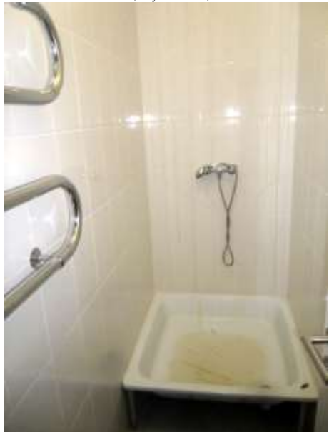
Фото 68 Часть помещения № 43, душевая
