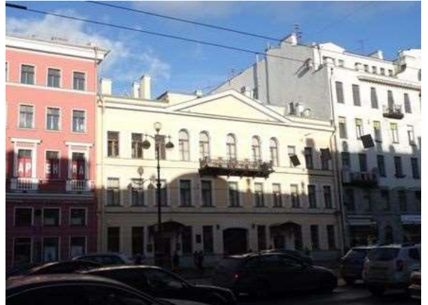
Фото 6 Здание, в котором расположен объект оценки, вид с Невского пр.
