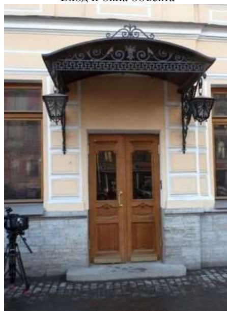
Фото 12 Вход в помещение со стороны Невского пр.
