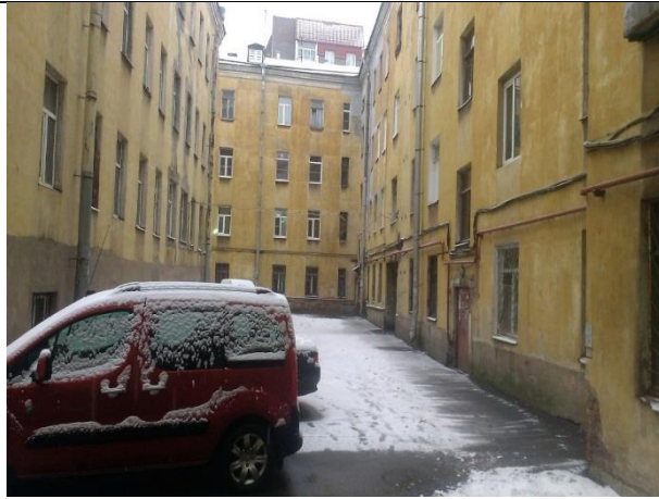
Вид фасада здания, в котором расположен объект оценки
