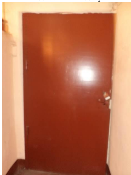
Фото 8 Вид входа в объект оценки
