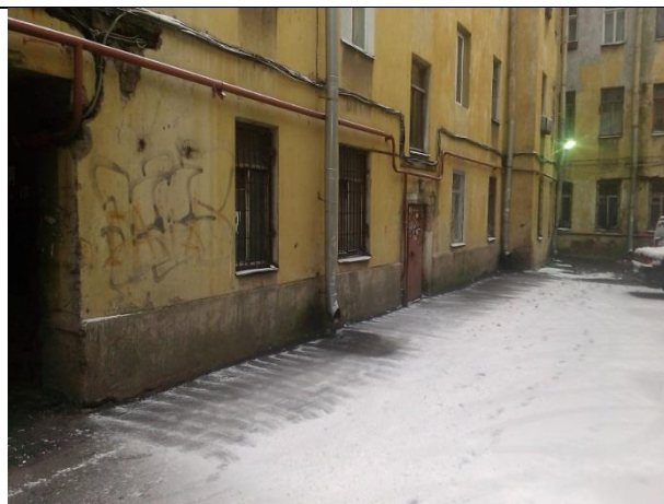
Фото 6 Вид здания со двора
