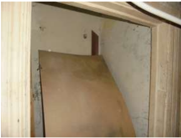
Фото 11 Общий вид и состояние кладовой (ч.п. № 7)
