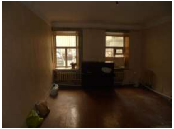
Фото 14 Общий вид и состояние комнаты (ч.п. № 10)
