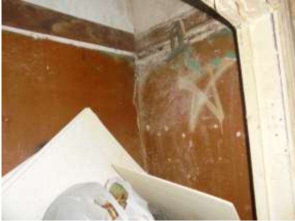
Фото 12 Общий вид и состояние кладовой (ч.п. № 8)
