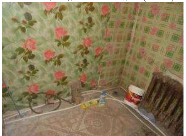
Фото 9 Общий вид и состояние ванной (ч.п. № 5)
