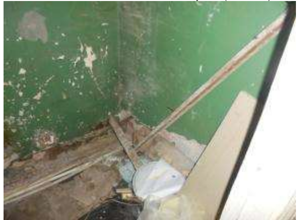
Фото 8 Общий вид и состояние кладовой (ч.п. № 4)
