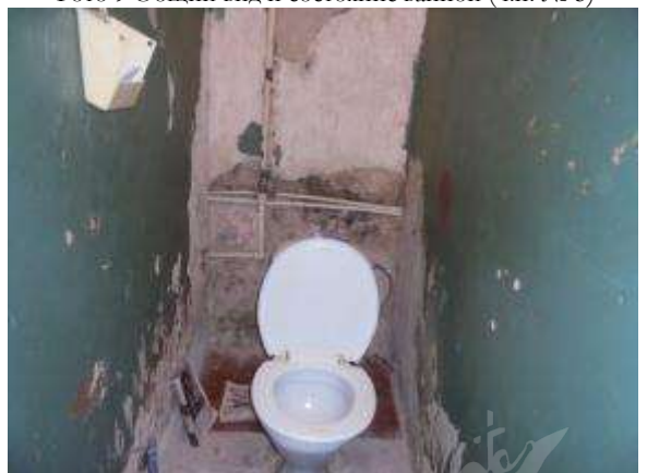
Фото 10 Общий вид и состояние туалета (ч.п. № 6)
