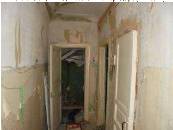
Фото 6 Общий вид и состояние коридора (ч.п. № 2)
