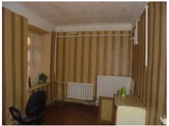
Фото 7 Общий вид и состояние кухни (ч.п. № 3)
