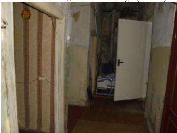
Фото 5 Общий вид и состояние коридора (ч.п. № 2)
