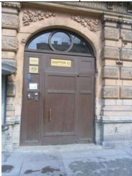
Фото 11 Вид входа в подъезд с улицы
