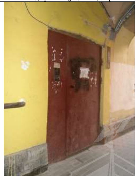
Фото 12 Вид входа в подъезд со двора
