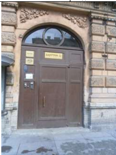
Фото 11 Вид входа в подъезд с улицы
