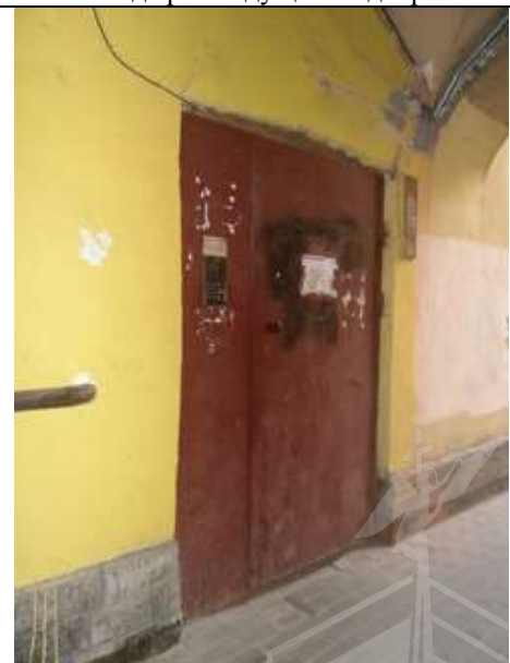
Фото 12 Вид входа в подъезд со двора
