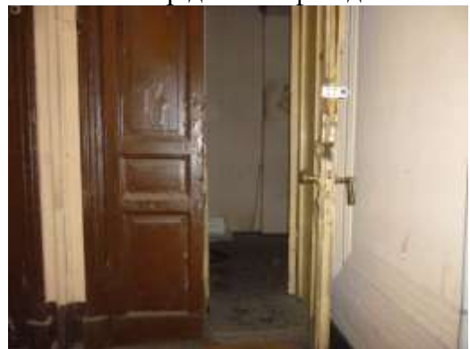
Вход в квартиру
