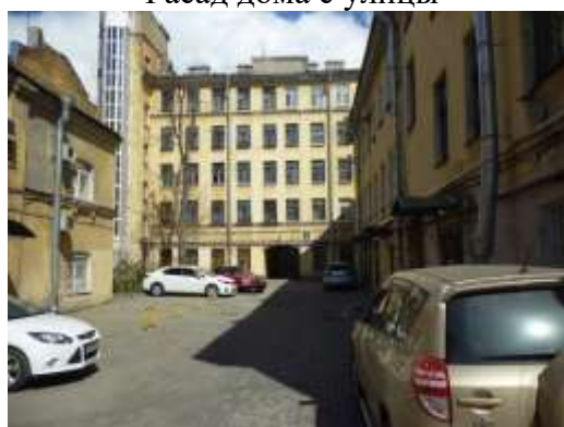
Состояние дворовой территории
