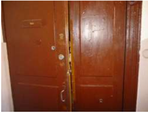
Вход в квартиру
