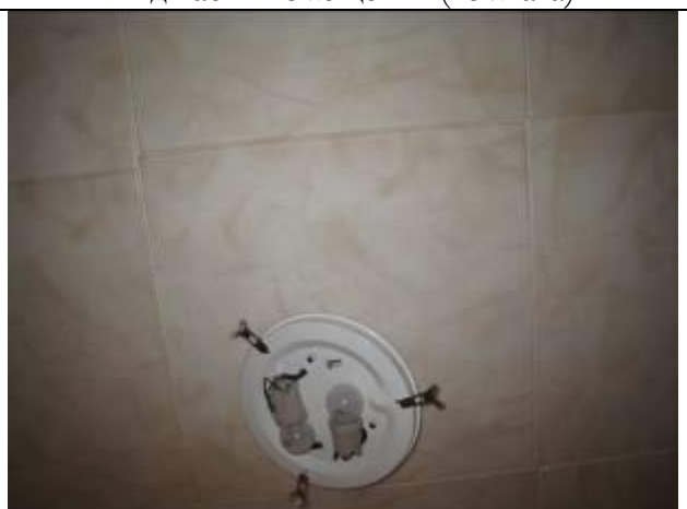
Фото 22 Вид потолка части помещения
