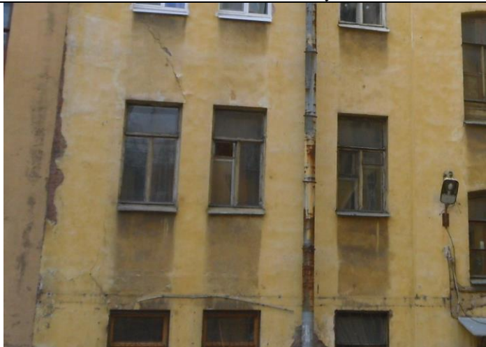
Фото 11 Вид окон объекта оценки со двора
