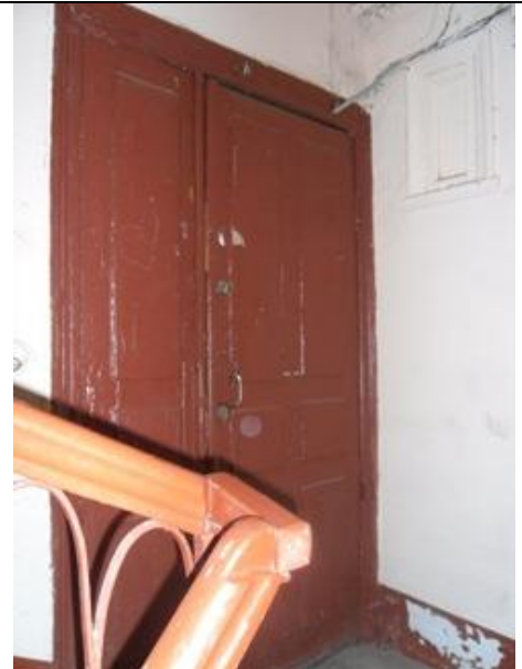
Фото 14 Вид входа в квартиру
