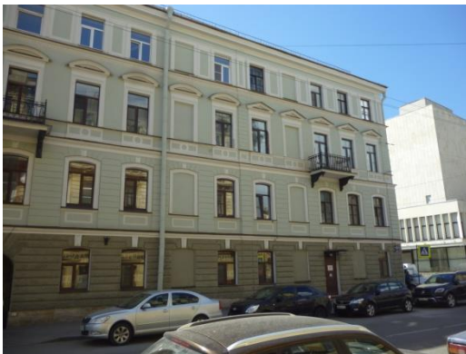
Общий вид дома с улицы
