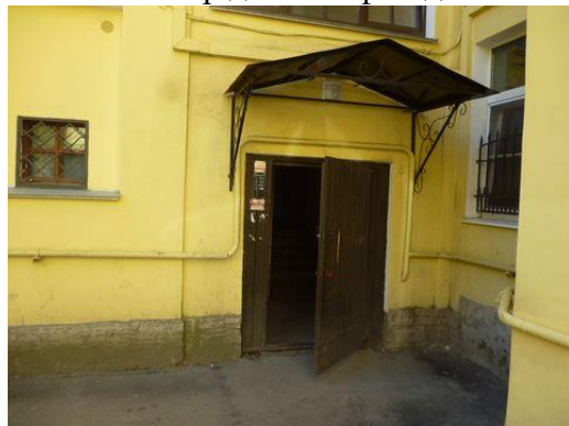
Общий вход со двора кв. 21, 23, 25
