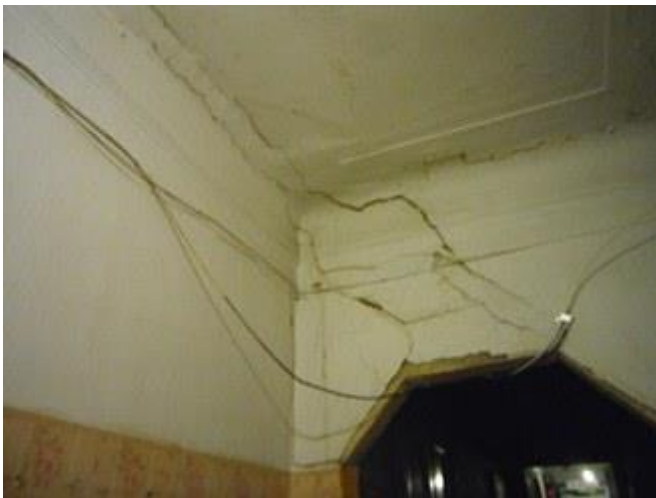
Фото 47 Вид части помещения №7
