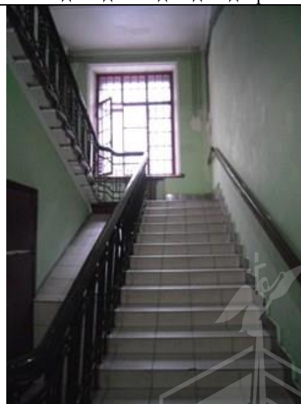
Фото 12 Вид подъезда (вход с улицы)
