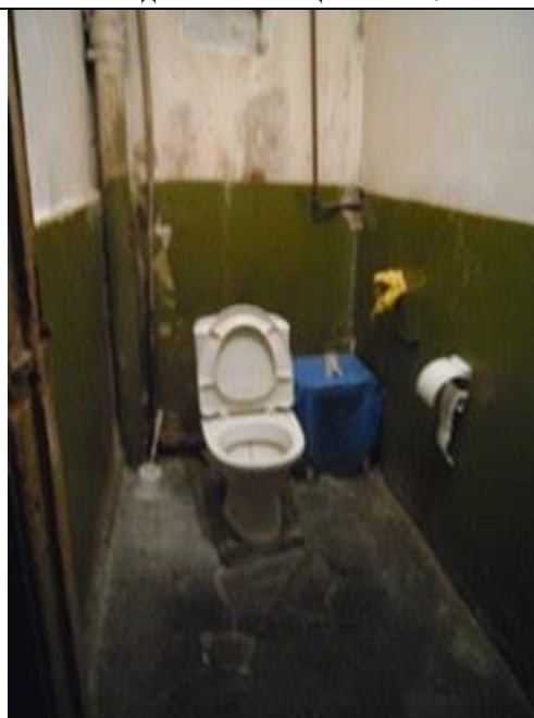
Фото 58 Вид части помещения №11
