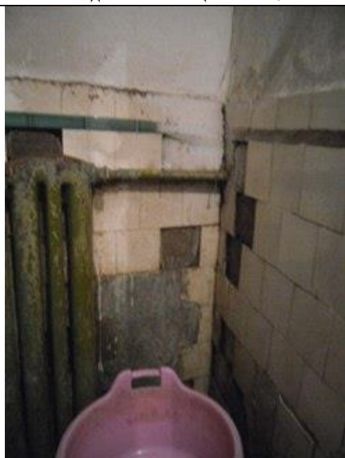
Фото 57 Вид части помещения №10
