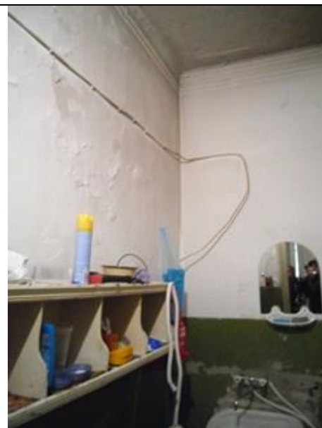
Фото 56 Вид части помещения №10
