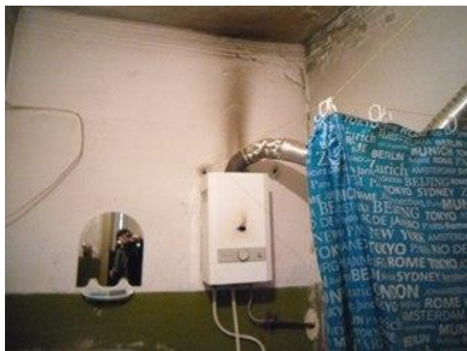
Фото 55 Вид части помещения №10
