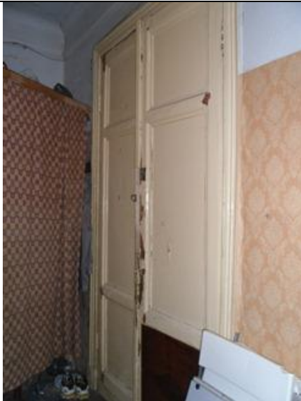
Фото 45 Вид части помещения №7
