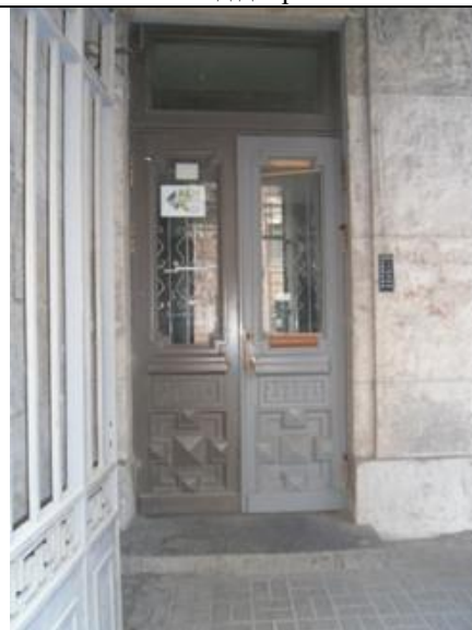
Фото 10 Вид входа в подъезд со двора
