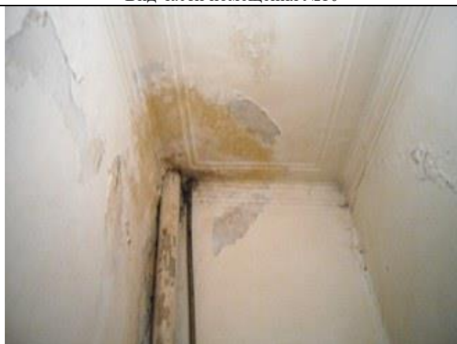
Фото 59 Вид части помещения №11
