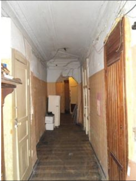
Фото 43 Вид части помещения №7
