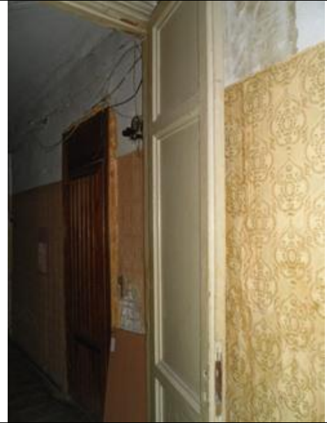
Фото 44 Вид части помещения №7
