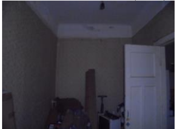
Фото 5 Общий вид и состояние кладовой (ч.п. № 11)
