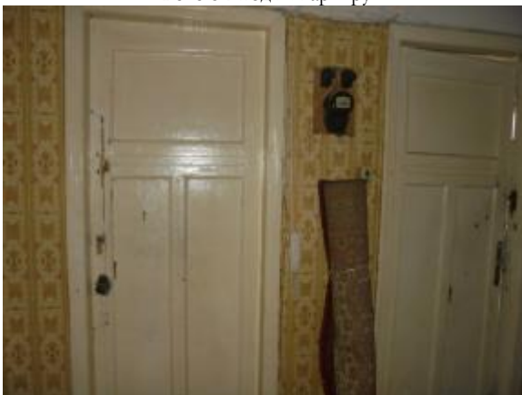
Фото 7 Общий вид и состояние коридора (ч.п. № 1)
