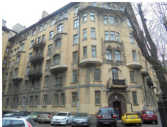
Фото 2 Фасад здания со стороны двора
