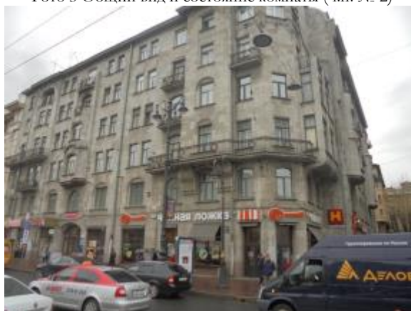
Фото 6 Общий вид дома (со стороны Лиговского проспекта)
