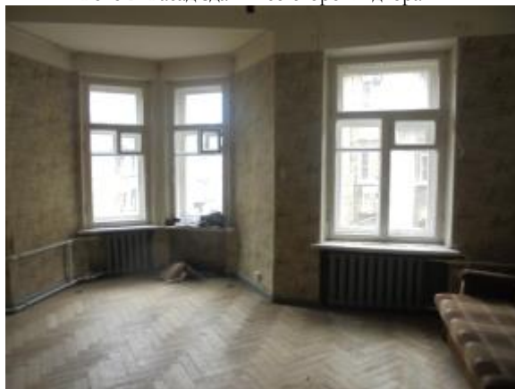
Фото 3 Общий вид и состояние комнаты (ч.п. № 2)
