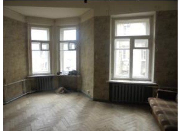
Фото 3 Общий вид и состояние комнаты (ч.п. № 2)
