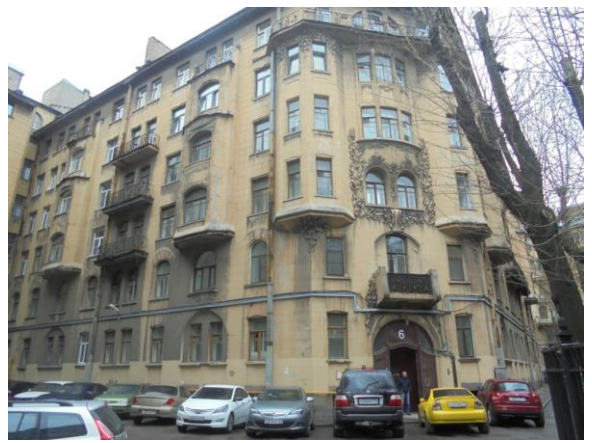
Фото 2 Фасад здания со стороны двора
