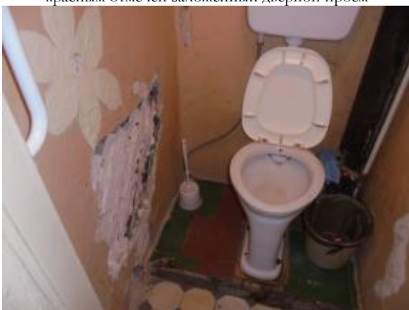
Фото 14 Общий вид и состояние туалета (ч.п. № 9)
