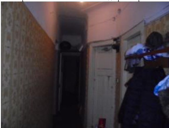
Фото 11 Общий вид и состояние коридора (ч.п. № 7)
