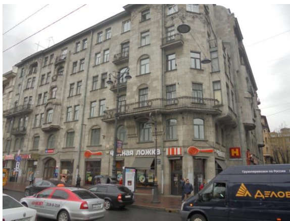
Фото 1 Фасад здания со стороны улицы
