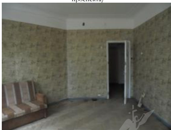
Фото 8 Общий вид и состояние комнаты (ч.п. № 3)
