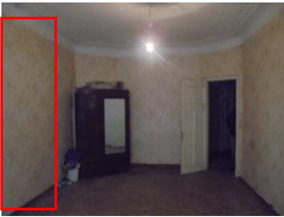
Фото 9 Общий вид и состояние комнаты (ч.п. № 4), красным отмечен заложный дверной проем
