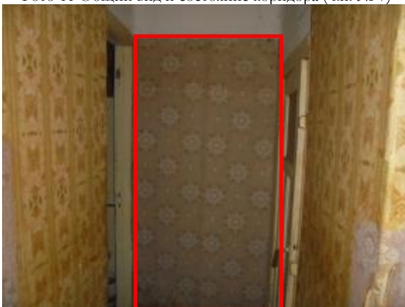
Фото 13 Общий вид и состояние коридора (ч.п. № 8), красным отмечен заложный дверной проем
