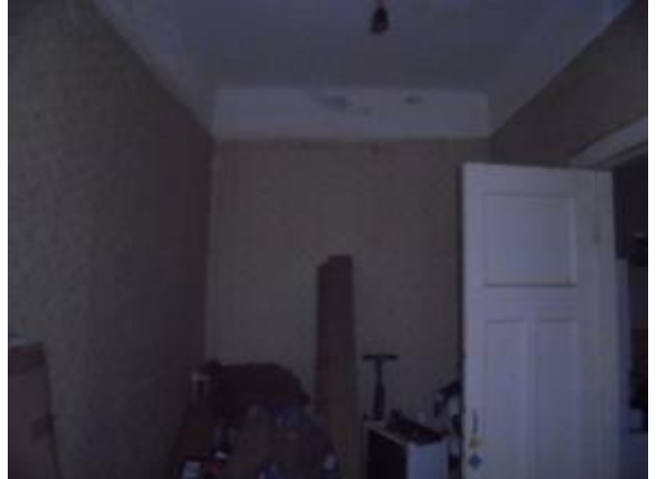
Фото 5 Общий вид и состояние кладовой (ч.п. № 11)
