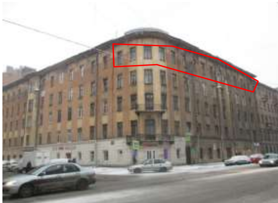
Фото 3 Фасад дома с улицы, в котором расположена оцениваемая квартира и окна, выходящие на улицу
