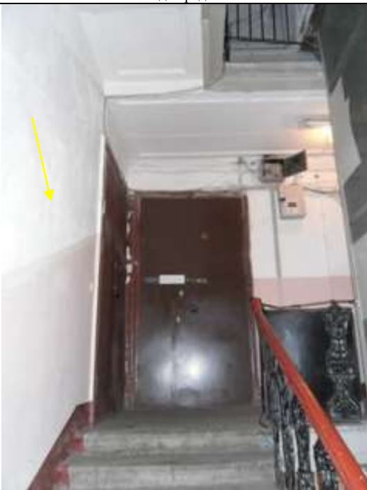
Фото 15 Вид входа в квартиру
