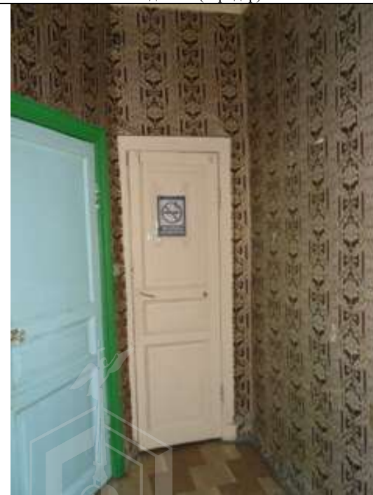
Фото 20 Вид ч.п. 1 (коридор, входы в ч.п. 6 и 7)
