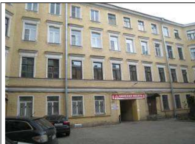
Фото 11 Вид здания 1-го двора
