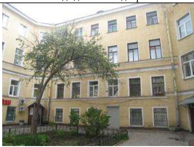
Фото 14 Вид здания 2-го двора
