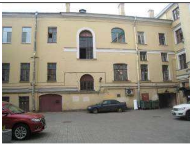
Фото 12 Вид здания 1-го двора
