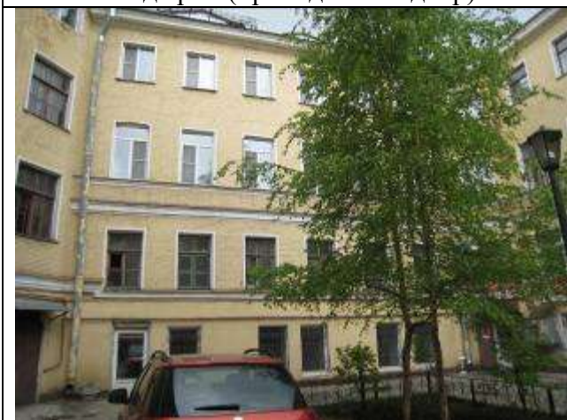
Фото 15 Вид здания 2-го двора
