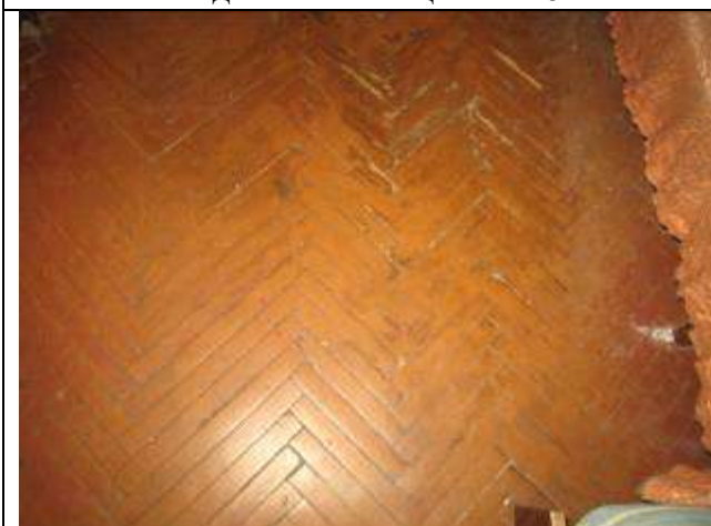
Фото 27 Вид пола части помещения №5
