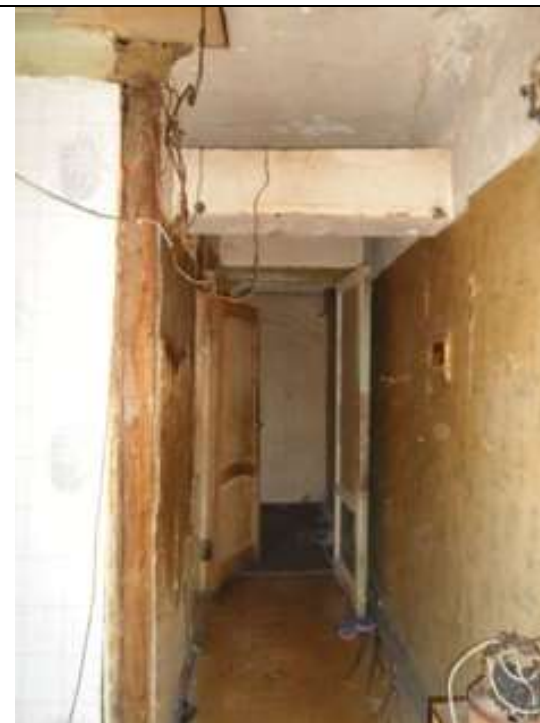
Фото 25 Вид ч.п. 3 (кухня-коридор)
