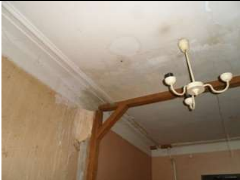
Фото 36 Вид ч.п. 2 (комната)
