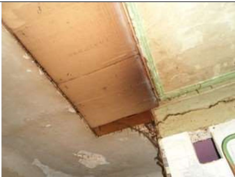
Фото 28 Вид ч.п. 3 (кухня-коридор)
