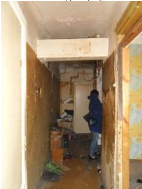
Фото 26 Вид ч.п. 3 (кухня-коридор)
