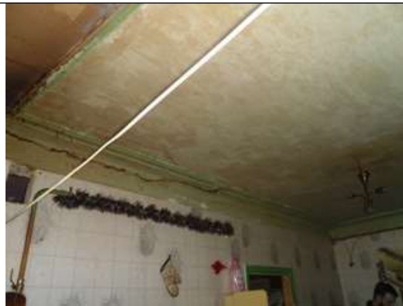
Фото 29 Вид ч.п. 3 (кухня-коридор)
