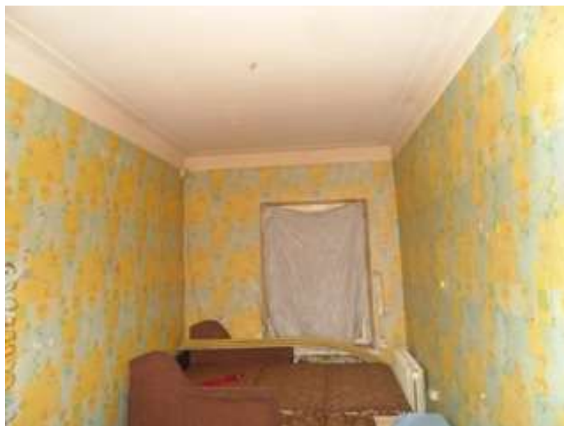
Фото 34 Вид ч.п. 1 (комната)
