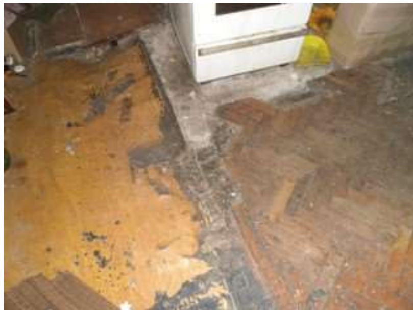
Фото 32 Вид ч.п. 3 (кухня-коридор)
