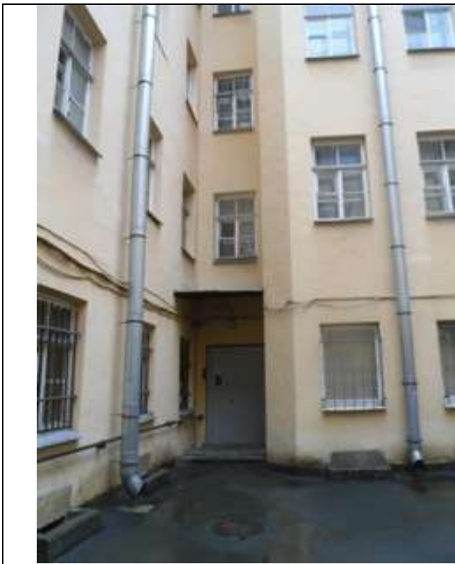
Фото 9 Вид входа в подъезд
