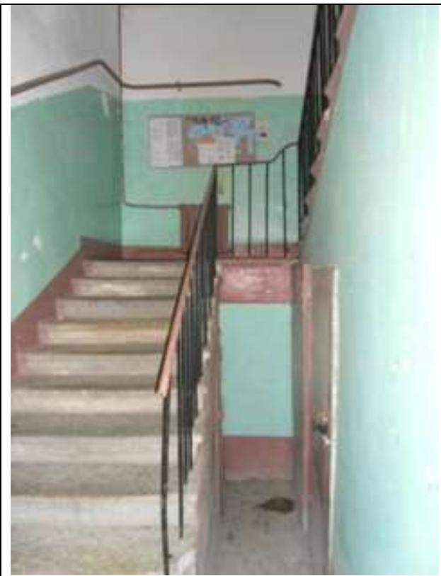
Фото 11 Вид лестничной клетки
