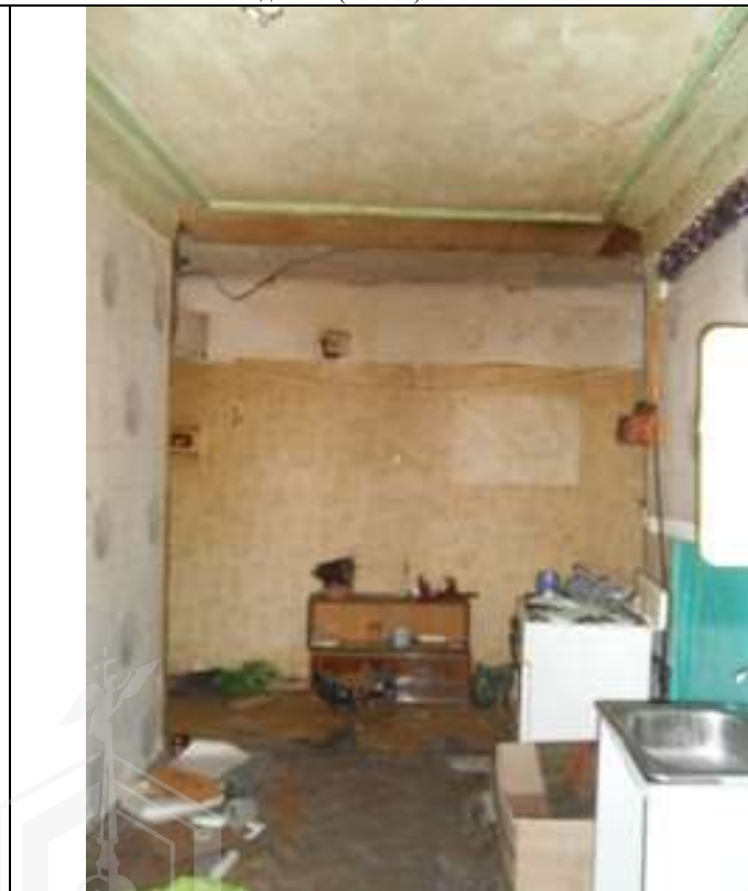
Фото 23 Вид ч.п. 3 (кухня-коридор)
