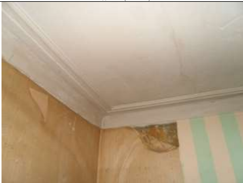
Фото 38 Вид ч.п. 2 (комната)
