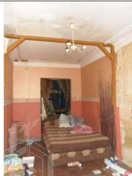
Фото 35 Вид ч.п. 2 (комната)
