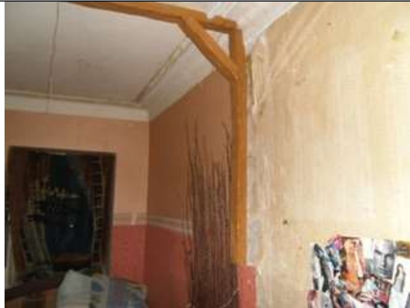
Фото 37 Вид ч.п. 2 (комната)
