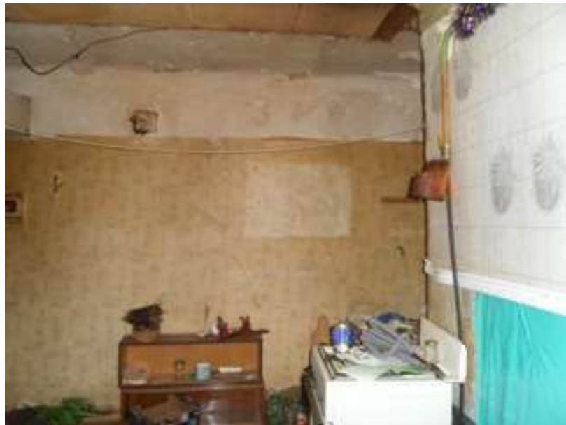
Фото 24 Вид ч.п. 3 (кухня-коридор)
