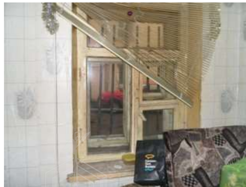
Фото 27 Вид ч.п. 3 (кухня-коридор)
