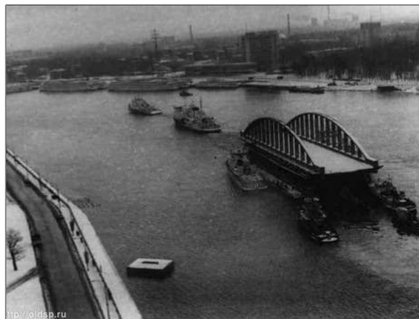
Рисунок 7 Процесс демонтажа арочных пролетных строений
