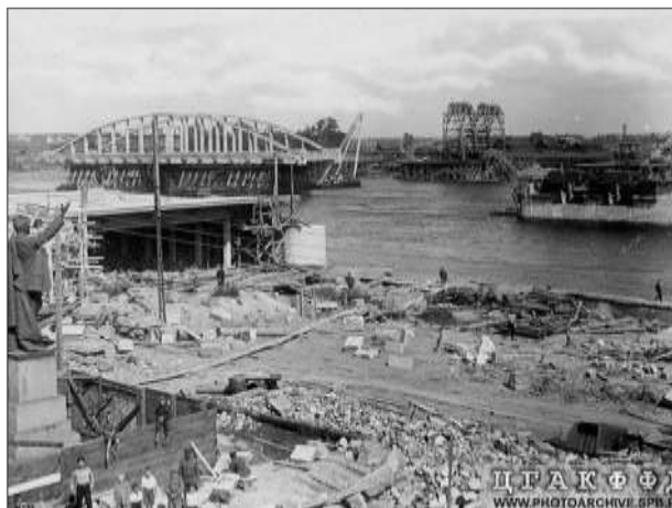
Рисунок 3. Процесс строительства Володарского моста 1936г. постройки
