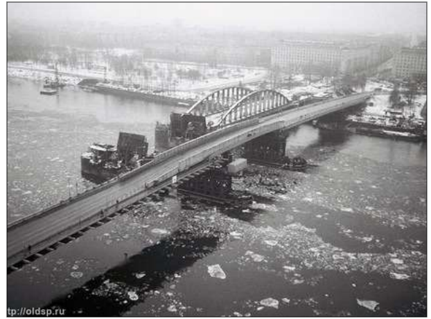
Рисунок 6 Процесс демонтажа арочных пролетных строений
