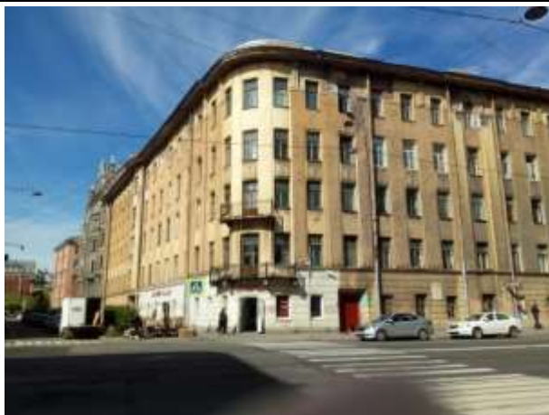
Фото 1. Вид части фасада жилого дома.
