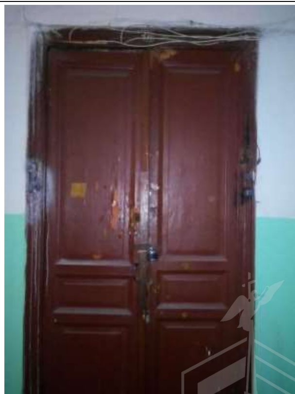
Фото 6. Входная дверь в квартиру.
