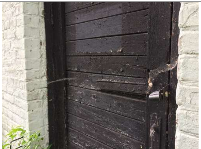
Рис. 6 Дверной проем здания
