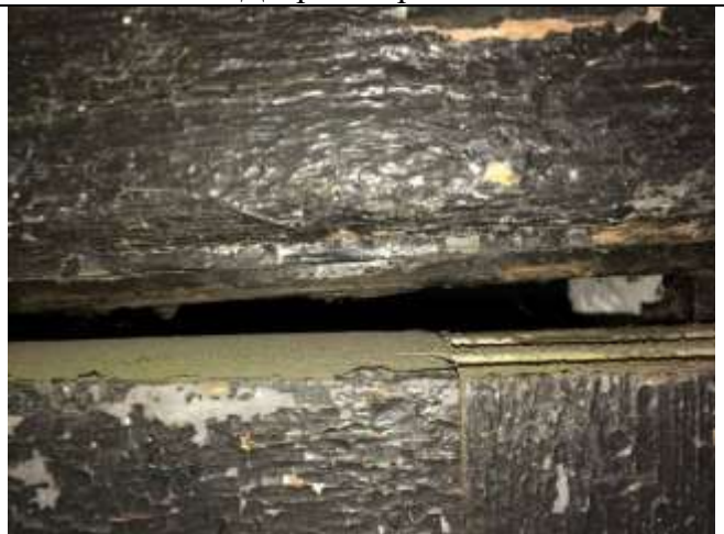
Рис. 8 Дверной проем здания
