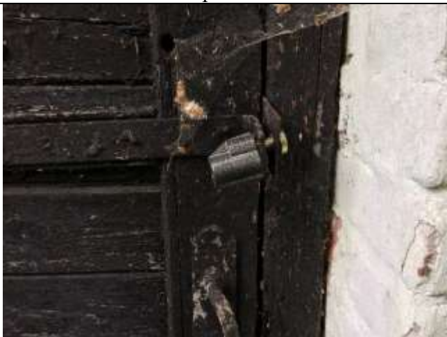
Рис. 7 Дверной проем здания
