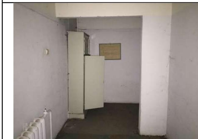
Фото 21: Ч.п.7, вид на ч.п.4. Самовольная перепланировка: расширен дверной проем; отсутствует дверное полотно, обозначенное на плане
