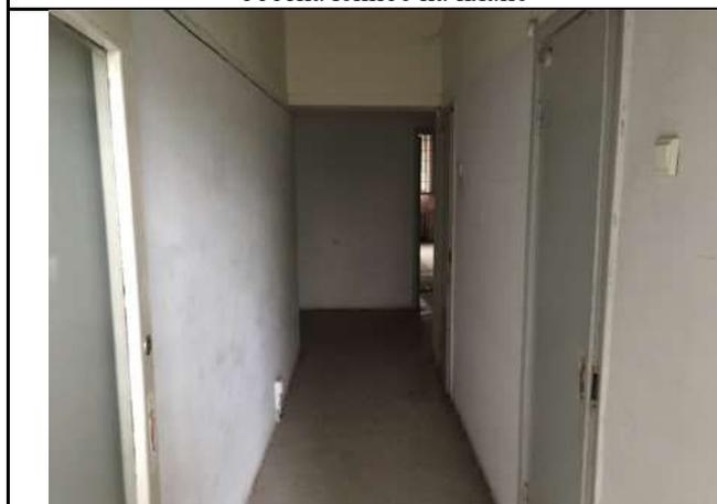
Фото 23: Ч.п.9 вид на ч.п.8 Самовольная перепланировка: расширен дверной проем между ч.п.9 и ч.п.8; отсутствует дверное полотно, обозначенное на плане
