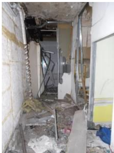
Фото 82 Состояние помещений (корридор)
