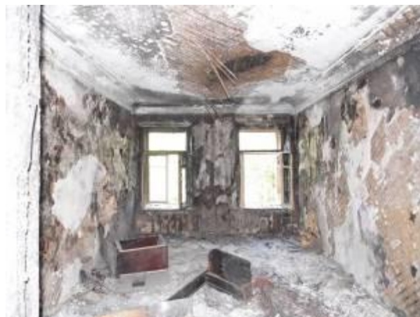
Фото 88 Общий вид комнаты
