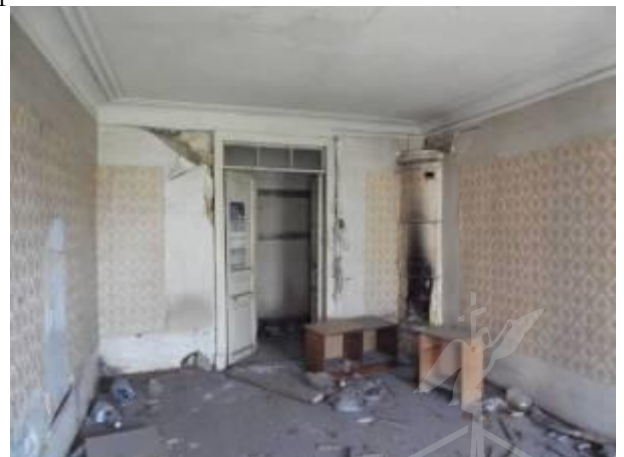
Фото 96 Общий вид комнаты
