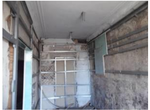
Фото 94 Общий вид кухни
