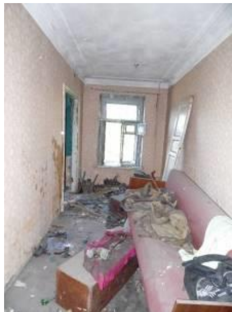
Фото 86 Общий вид помещений (жилая комната) Квартира 49
