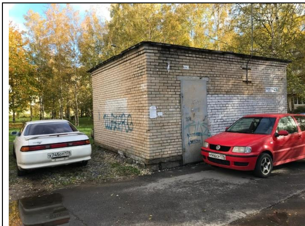
Фото 5. Оцениваемый объект недвижимости – здание насосной станции
