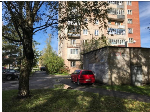
Фото 6. Оцениваемый объект недвижимости – здание насосной станции. Ближайшее окружение – многоквартирный жилой дом (Колпинское шоссе, дом 47)
