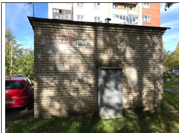
Фото 1. Оцениваемый объект недвижимости – здание насосной станции
