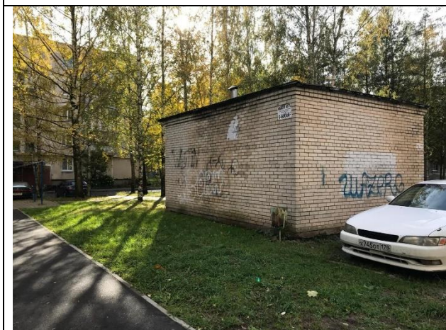
Фото 3. Оцениваемый объект недвижимости – здание насосной станции. Ближайшее окружение – многоквартирный жилой дом (Колпинское шоссе, дом 49)
