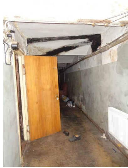
Фото 22 Общий вид и состояние квартиры
