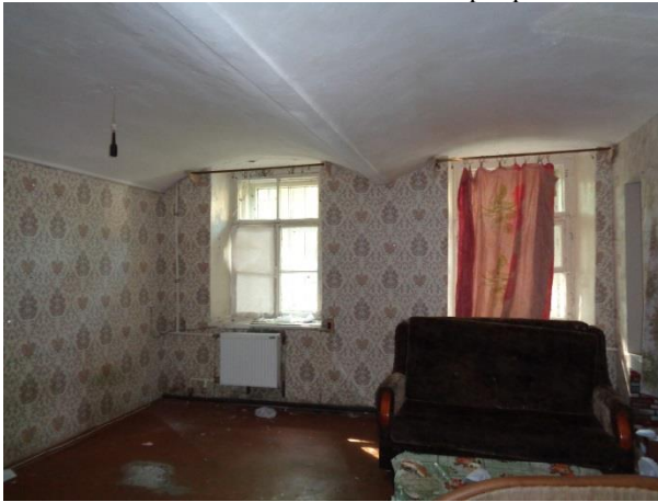
Фото 23 Общий вид и состояние квартиры
