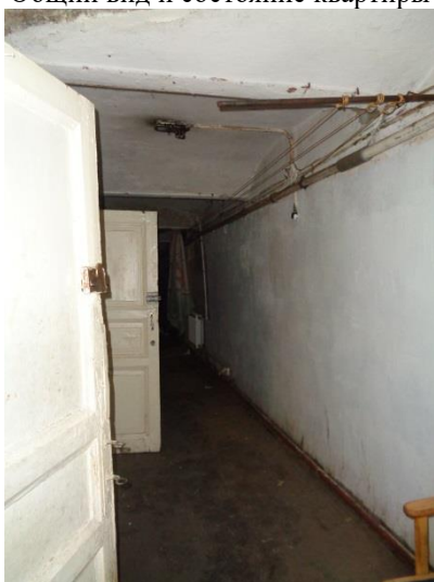
Фото 19 Общий вид и состояние квартиры
