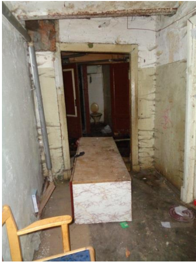
Фото 33 Общий вид и состояние квартиры
