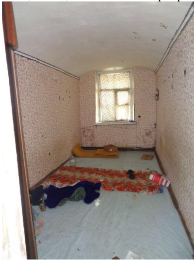
Фото 25 Общий вид и состояние квартиры
