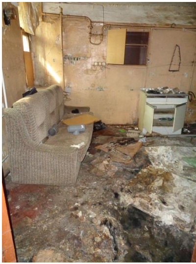
Фото 15 Общий вид и состояние квартиры
