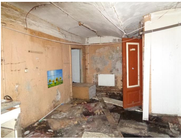
Фото 17 Общий вид и состояние квартиры
