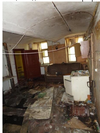
Фото 18 Общий вид и состояние квартиры
