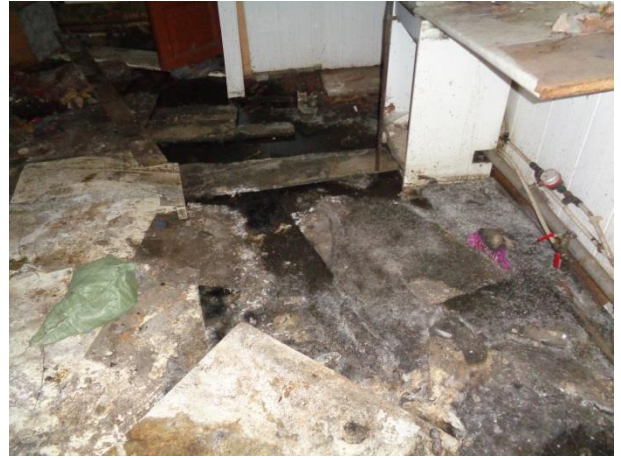
Фото 16 Общий вид и состояние квартиры
