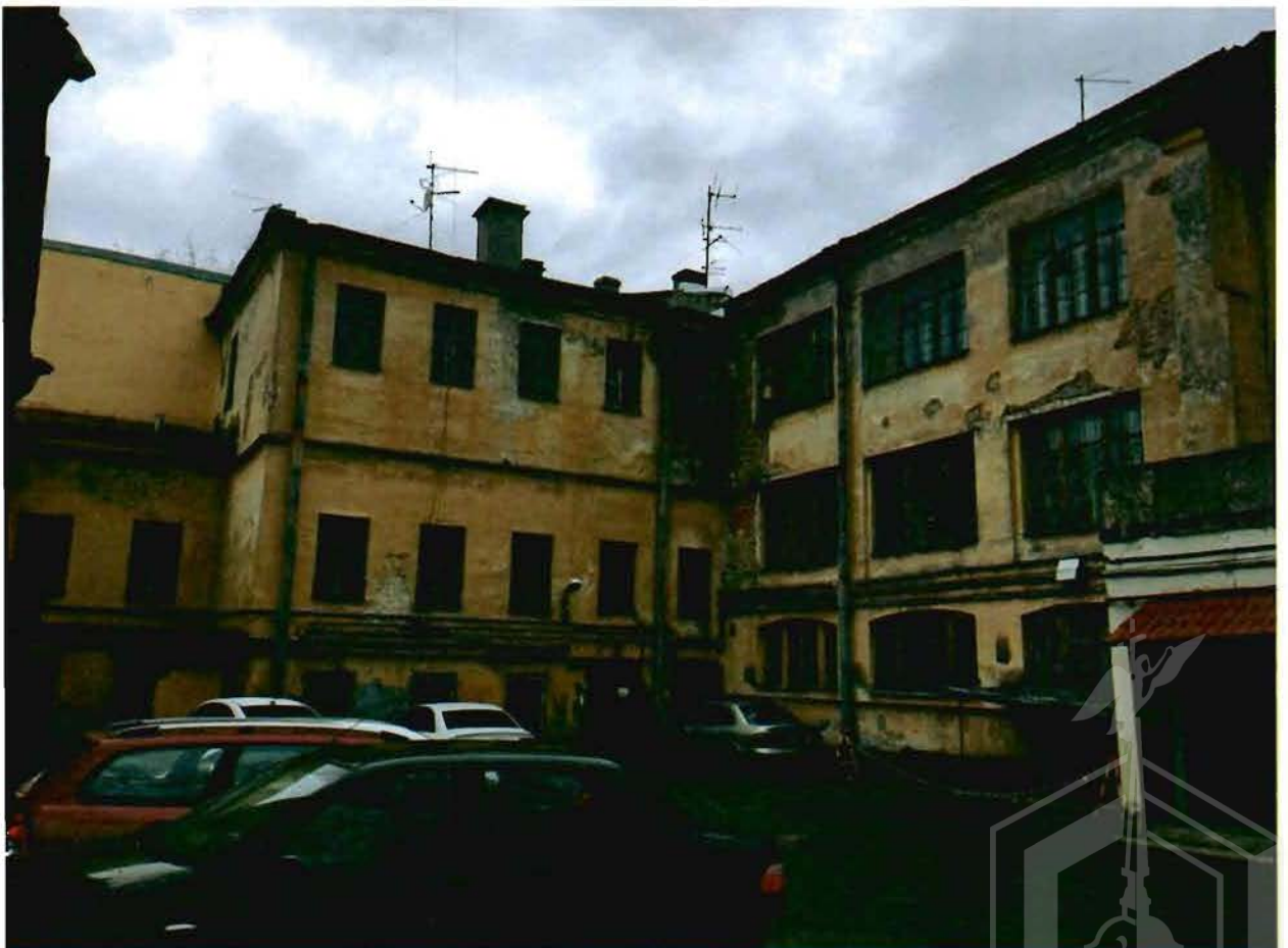
Фото 6. Южный и восточный дворовый фасад.
