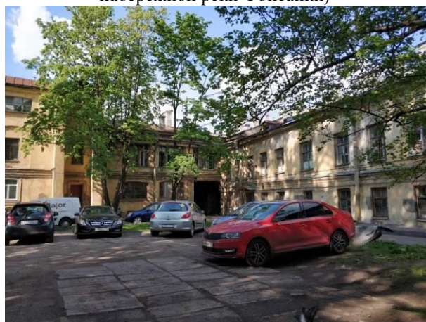
Фото 10. Вид на дом, в котором расположен объект оценки (со стороны двора)
