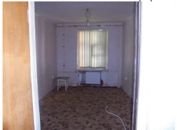
Фото 18. Общий вид и состояние квартиры
