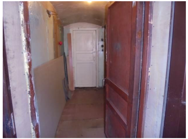
Фото 14. Общий вид и состояние квартиры
