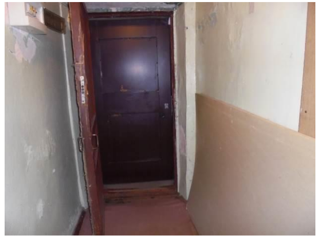
Фото 22. Общий вид и состояние квартиры
