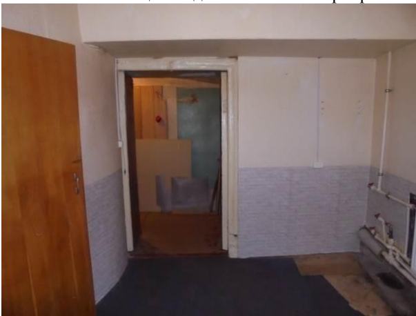
Фото 17. Общий вид и состояние квартиры
