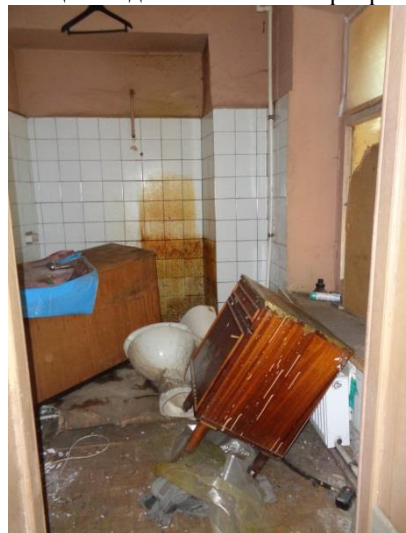
Фото 18 Общий вид и состояние квартиры
