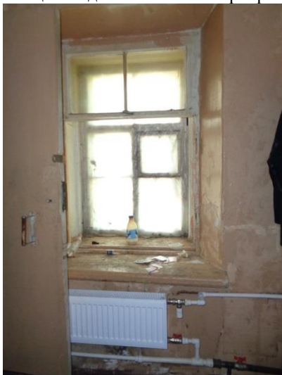
Фото 17 Общий вид и состояние квартиры
