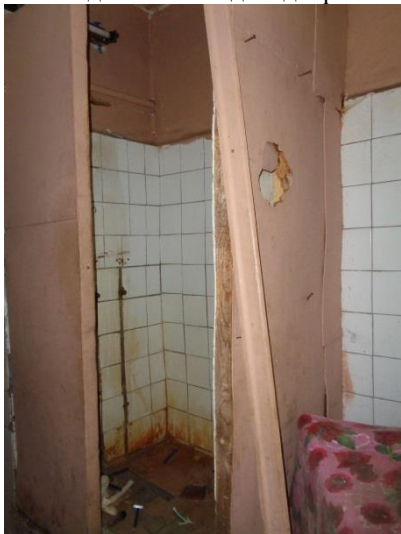
Фото 15 Общий вид и состояние квартиры
