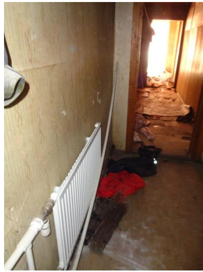
Фото 32 Общий вид и состояние квартиры
