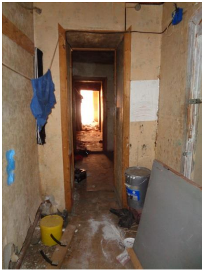
Фото 31 Общий вид и состояние квартиры
