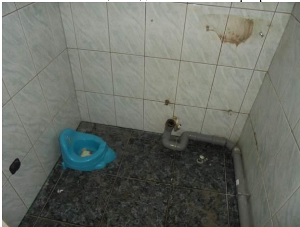
Фото 17. Общий вид и состояние квартиры
