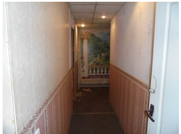
Фото 16. Общий вид и состояние квартиры
