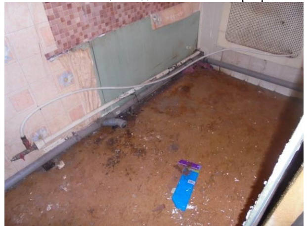
Фото 18. Общий вид и состояние квартиры
