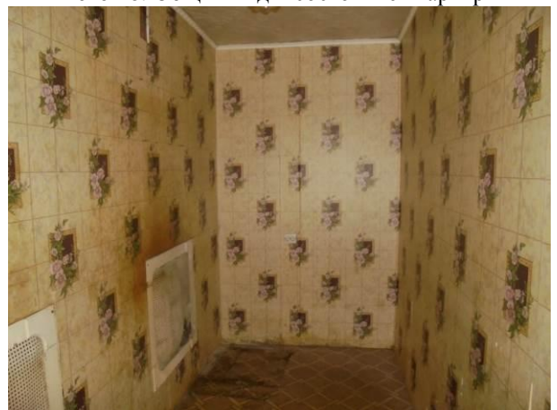
Фото 20. Общий вид и состояние квартиры
