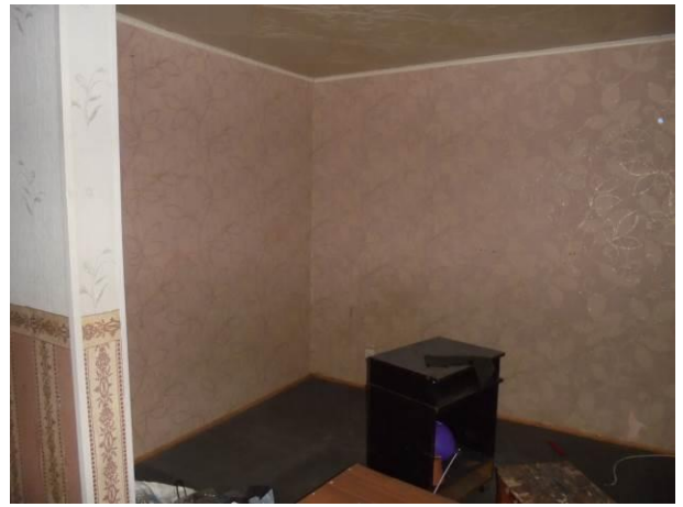
Фото 24. Общий вид и состояние квартиры
