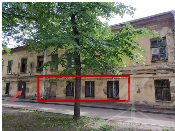
Фото 2. Вид на дом, в котором расположен объект оценки (со стороны двора). 4 окна объекта оценки
