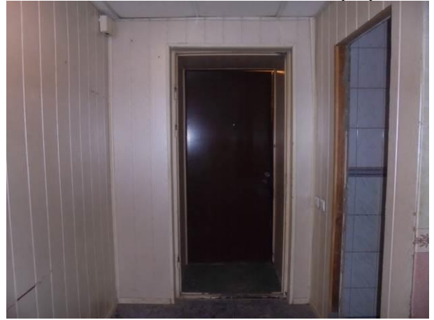
Фото 26. Общий вид и состояние квартиры
