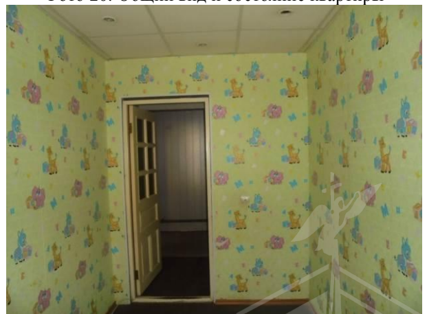
Фото 22. Общий вид и состояние квартиры
