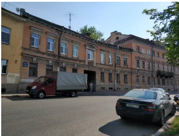
Фото 1. Вид на дом, в котором расположен объект оценки (со стороны набережной реки Фонтанки)
