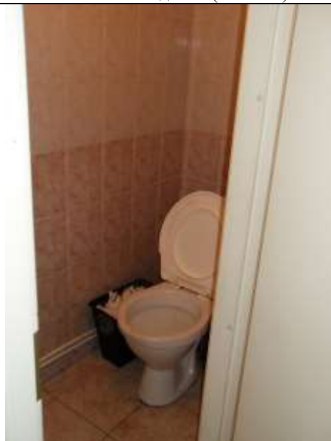
Фото 32 Состояние отделки (санузел)
