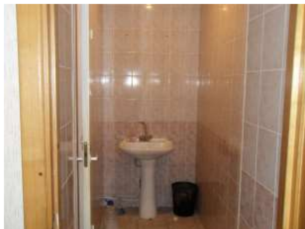
Фото 31 Состояние отделки (санузел)
