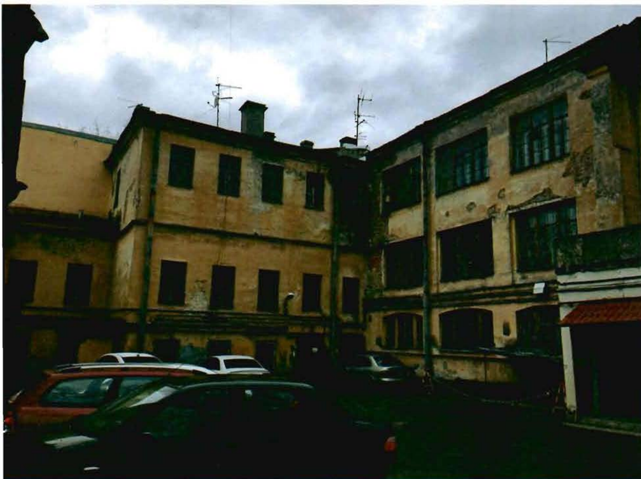
Фото 6. Южный и восточный дворový фасад.
