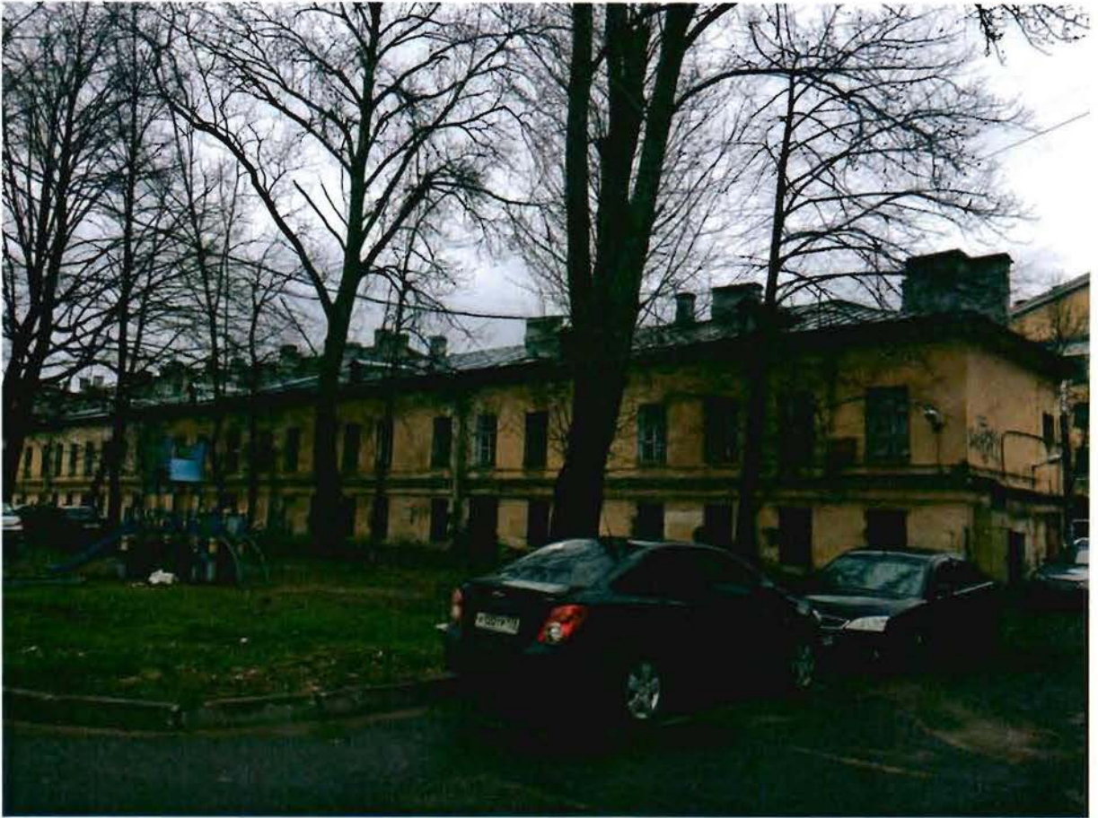
Фото 3. Западный дворовый фасад.
