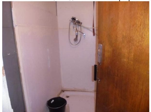
Фото 22. Общий вид и состояние квартиры
