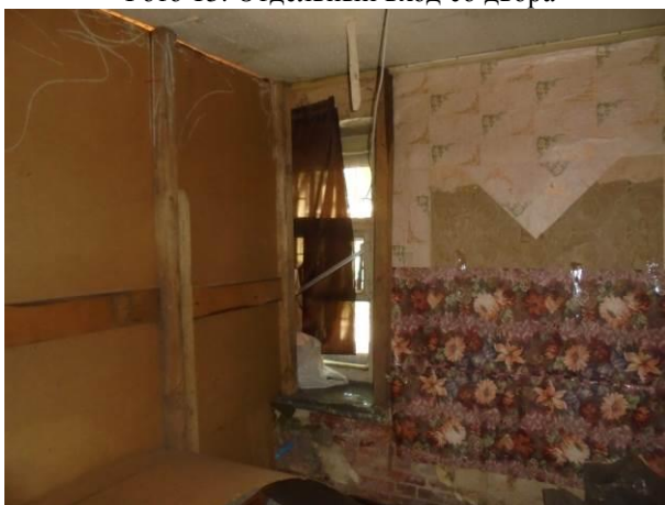
Фото 15. Общий вид и состояние квартиры
