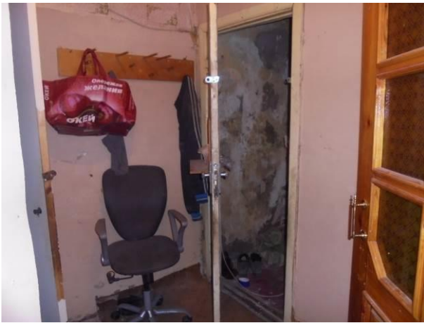
Фото 17. Общий вид и состояние квартиры
