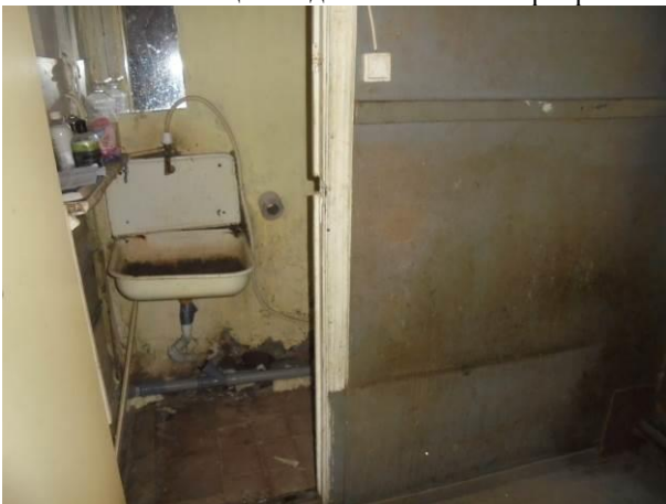
Фото 23. Общий вид и состояние квартиры
