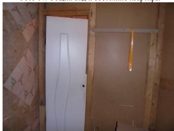
Фото 16. Общий вид и состояние квартиры
