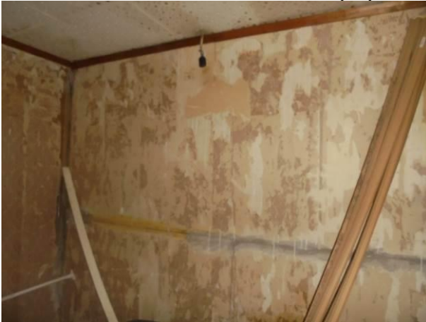
Фото 19. Общий вид и состояние квартиры
