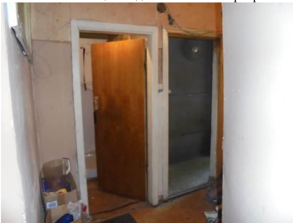
Фото 21. Общий вид и состояние квартиры
