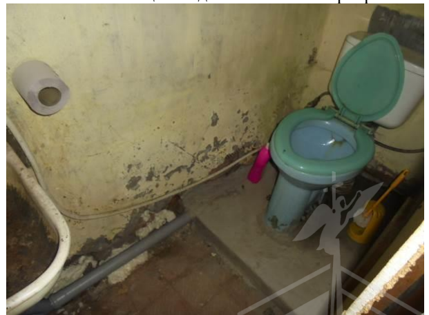
Фото 24. Общий вид и состояние квартиры
