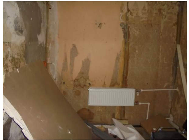
Фото 18. Общий вид и состояние квартиры
