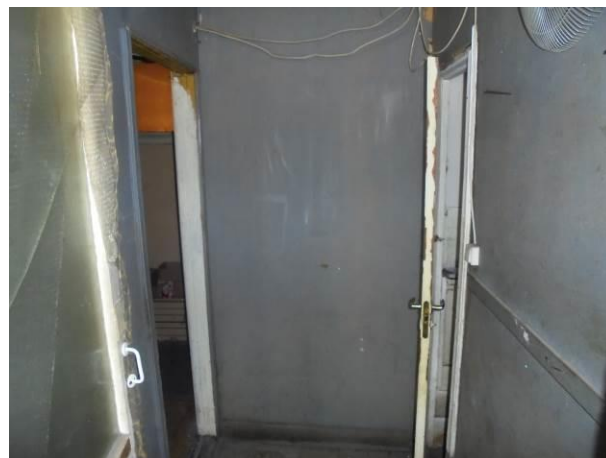
Фото 14. Общий вид и состояние квартиры
