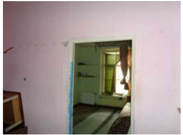
Фото 28. Общий вид и состояние квартиры
