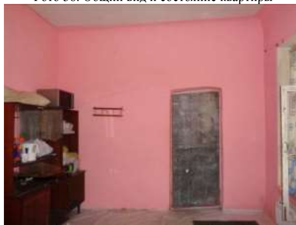
Фото 40. Общий вид и состояние квартиры
