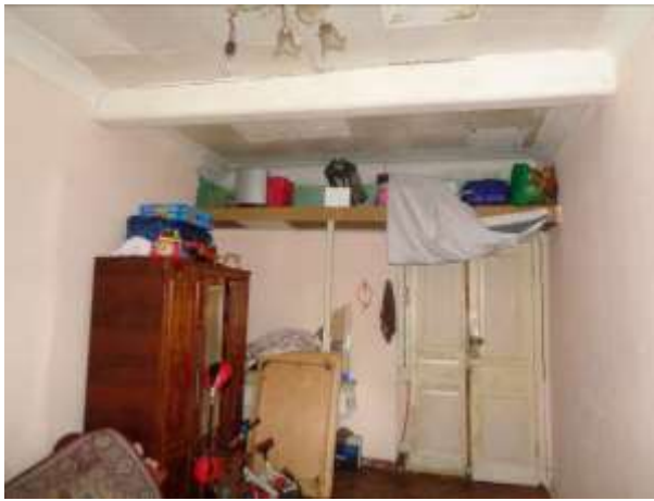
Фото 27. Общий вид и состояние квартиры
