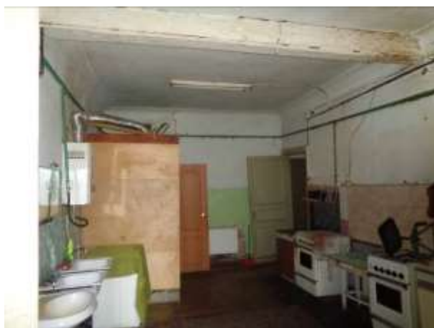
Фото 15. Общий вид и состояние квартиры
