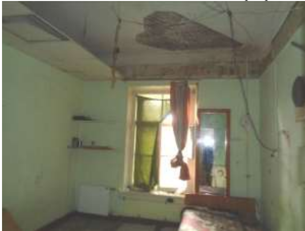
Фото 29. Общий вид и состояние квартиры
