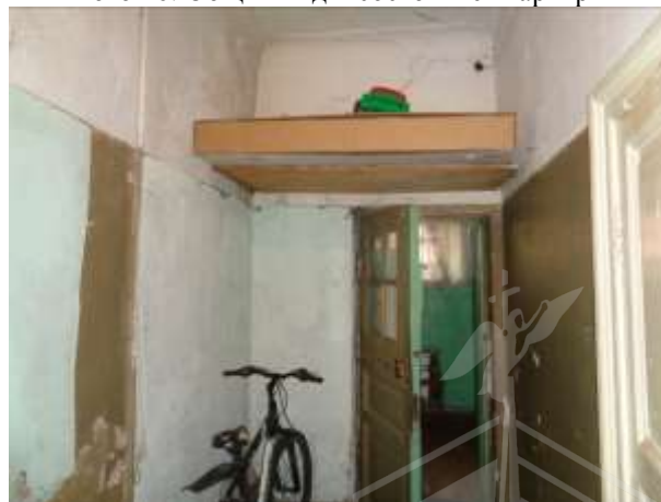
Фото 42. Общий вид и состояние квартиры
