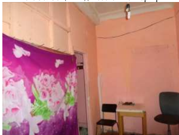
Фото 38. Общий вид и состояние квартиры
