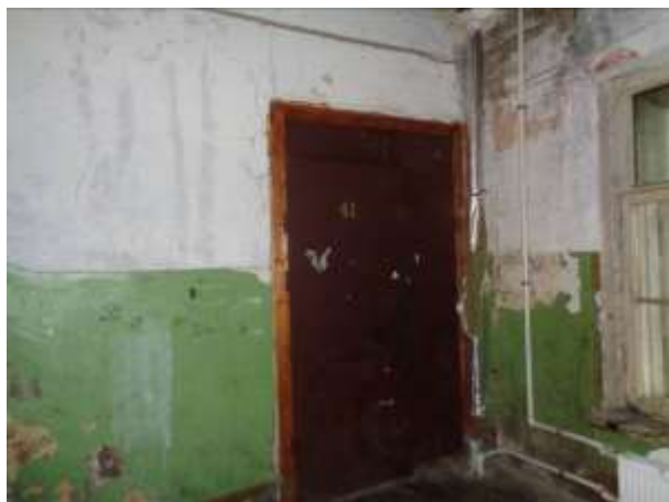
Фото 14. Вход в квартиру (общий с жилыми помещениями со двора)
