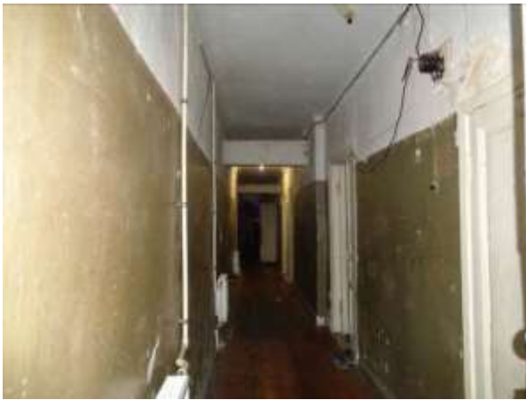
Фото 19. Общий вид и состояние квартиры
