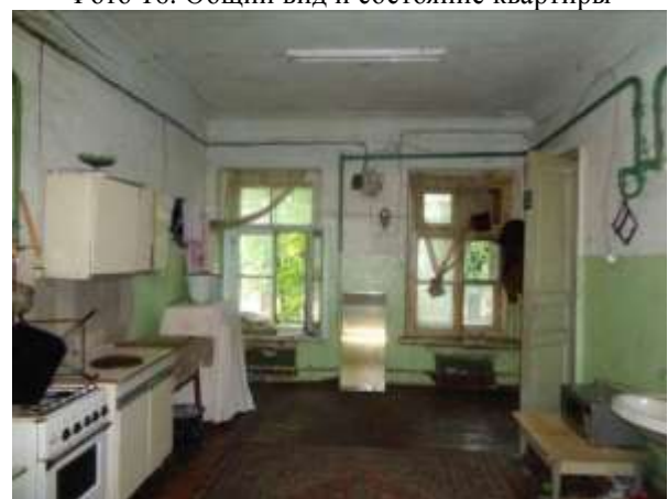
Фото 18. Общий вид и состояние квартиры
