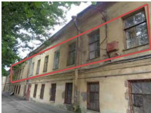
Фото 2. Вид на дом, в котором расположен объект оценки (со стороны двора). 13 окон объекта оценки с видом во двор.
