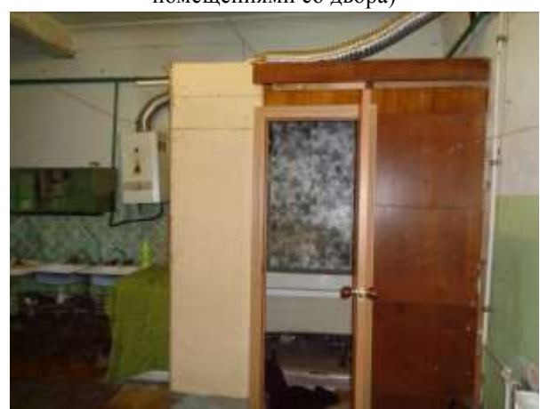
Фото 16. Общий вид и состояние квартиры
