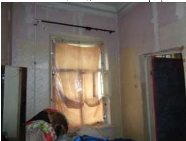
Фото 41. Общий вид и состояние квартиры
