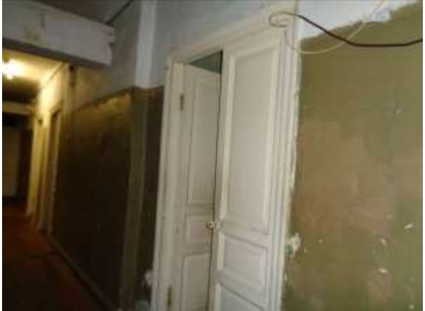
Фото 22. Общий вид и состояние квартиры
