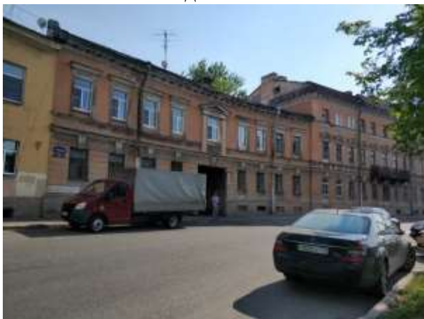
Фото 1. Вид на дом, в котором расположен объект оценки (со стороны набережной реки Фонтанки)
