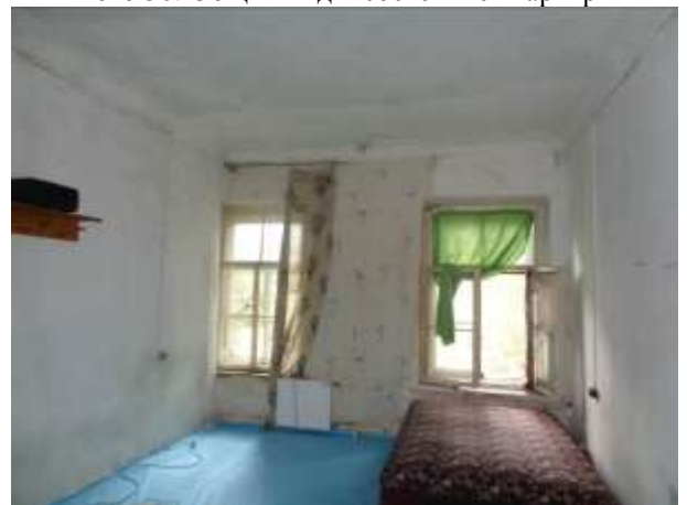
Фото 32. Общий вид и состояние квартиры
