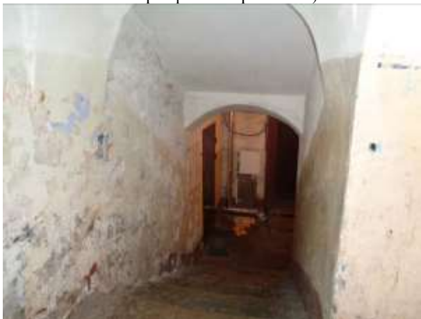
Фото 11. Общий вид и состояние помещений общего пользования (лестница)
