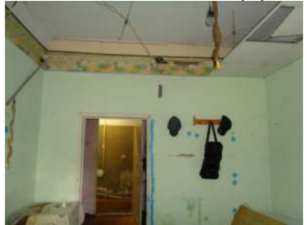
Фото 30. Общий вид и состояние квартиры
