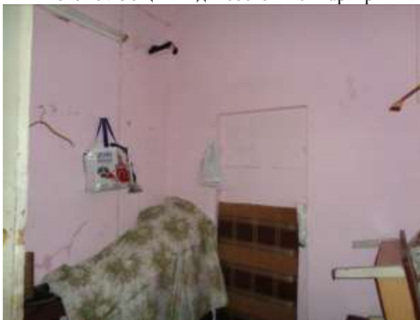
Фото 31. Общий вид и состояние квартиры
