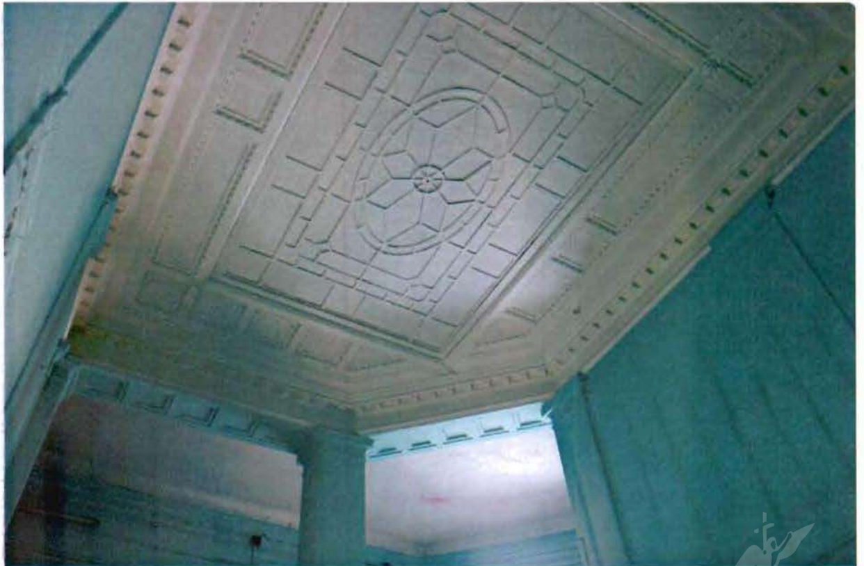
Фото № 22, 23, 24. Лестничная клетка Л-2 восточного корпуса.
