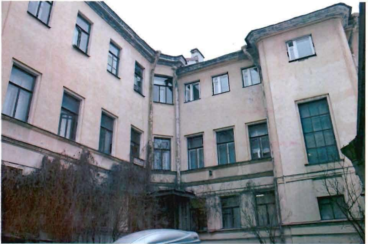
Фото №2. Вид на восточный и северный корпуса со стороны внутреннего двора.
