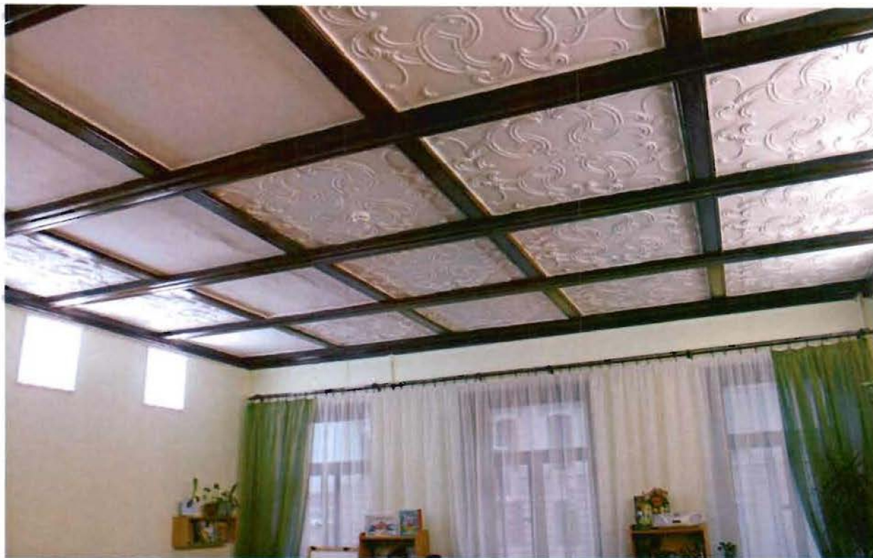
Фото № 15. Пом. 2-Н (32) 1-го этажа.
