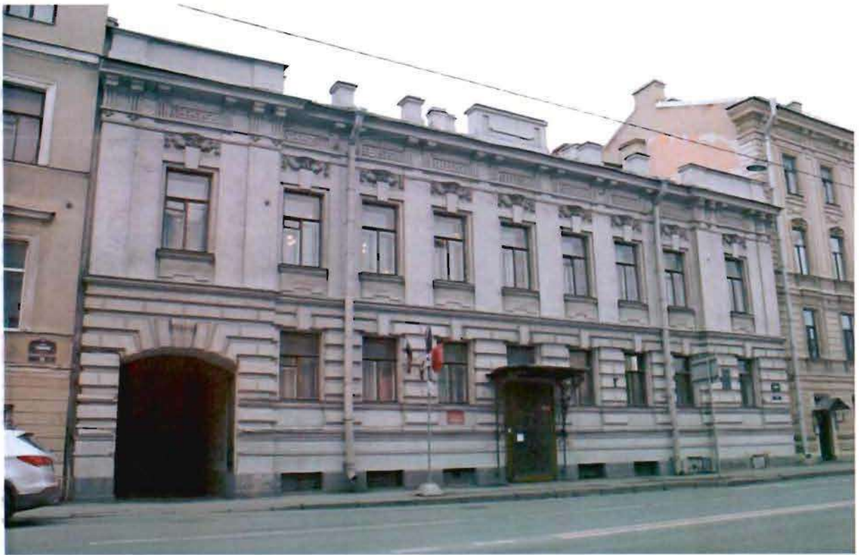
Фото №1. Вид на лицевой фасад со стороны ул. Глинки.
