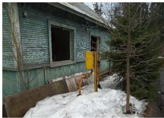
Фото №14 Вид фасада здания, вид окон
