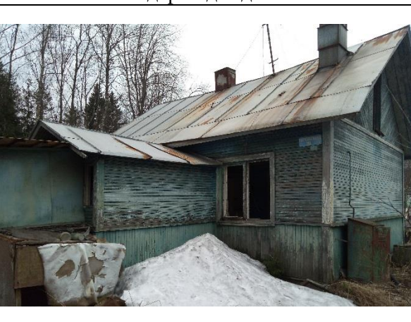
Фото №18 Вид фасада здания, вид окна
