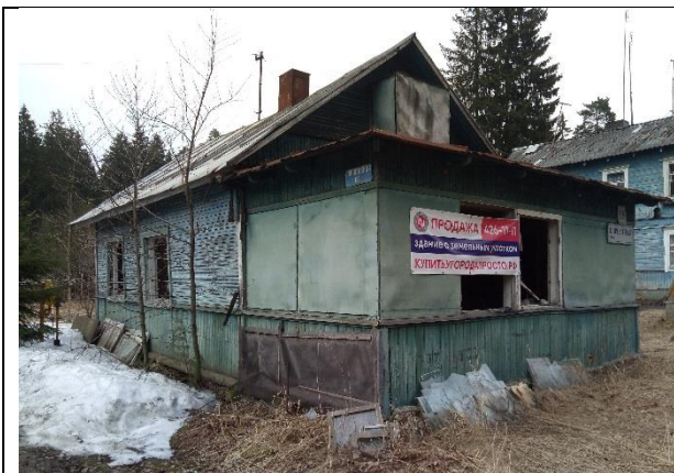
Фото №13 Вид фасада здания
