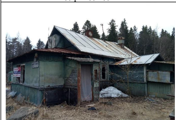
Фото №15 Вид фасада здания, вид окна
