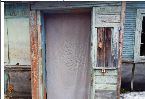
Фото №19 Вид входа в объект оценки (снаружи)
