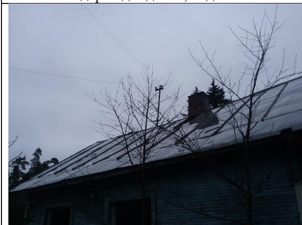
Фото №17 Вид крыши здания
