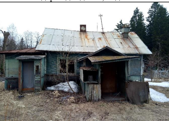
Фото №16 Вид фасада здания
