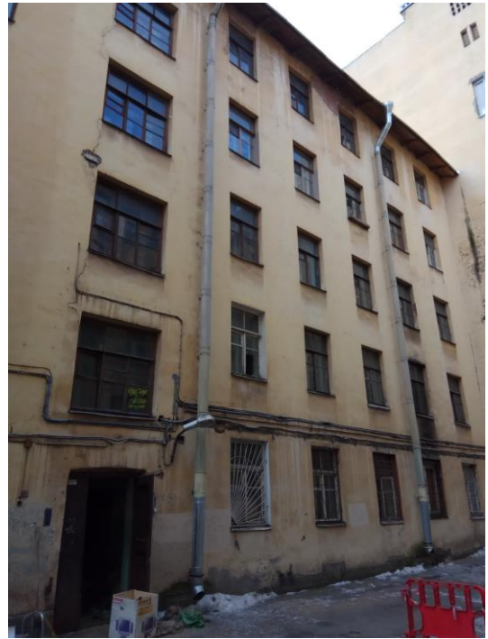
Фото 2 Фасад здания (со двора)
