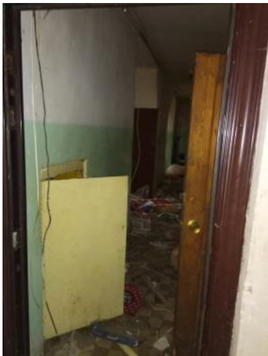
Фото 7 Вход в помещение
