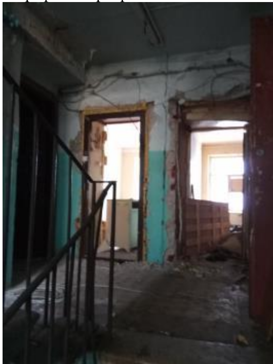
Фото 40 Вход в помещение
