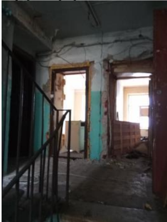
Фото 40 Вход в помещение
