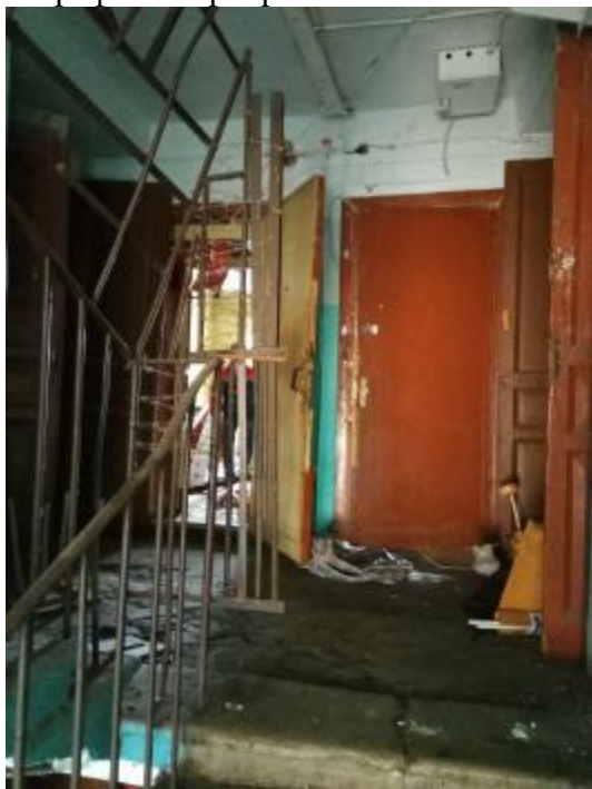
Фото 74 Вход в помещение
