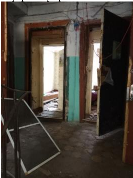
Фото 22 Вход в помещение
