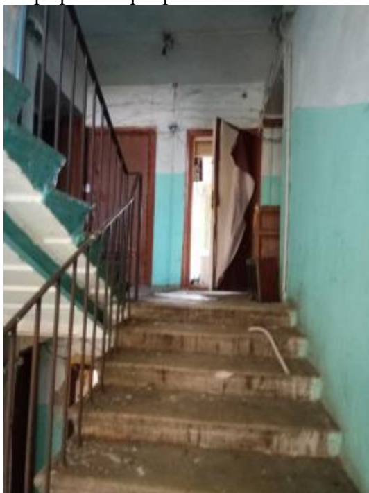
Фото 57 Вход в помещение
