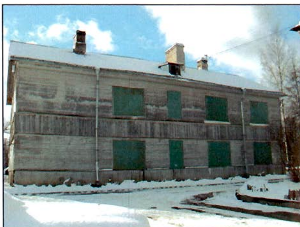
Фото 2. Фасад с северной стороны.
