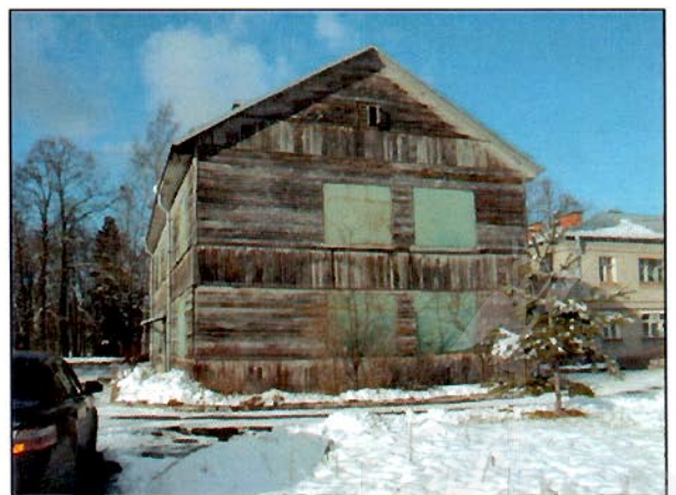
Фото 3. Фасад с восточной стороны.
