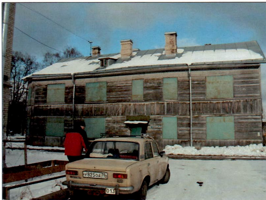
Фото 4. Фасад с южной стороны.
