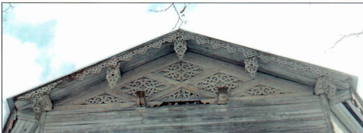
Фото 5. Фрагмент западного фасада.
