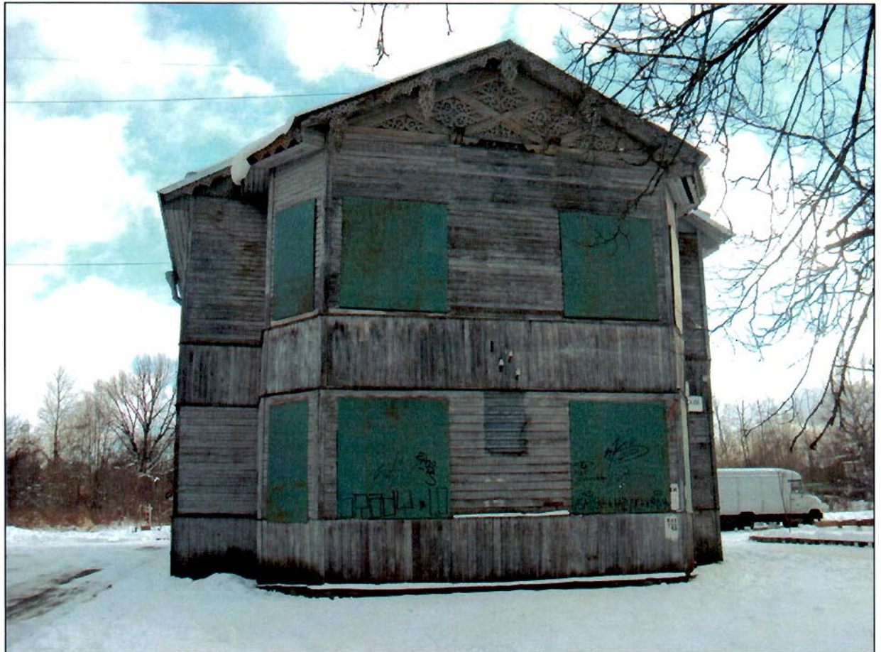
Фото 1. Фасад с западной стороны.
