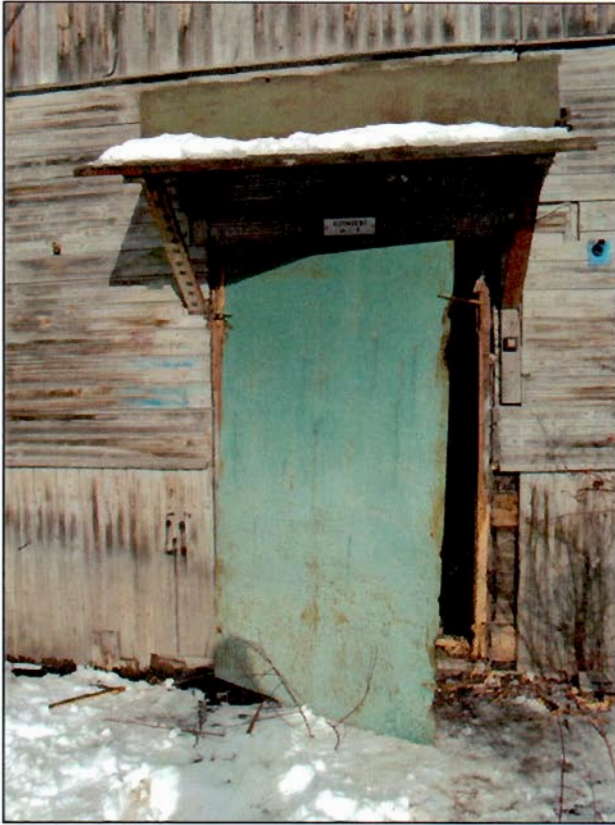
Фото 6. Крыльцо со стороны южного фасада.
