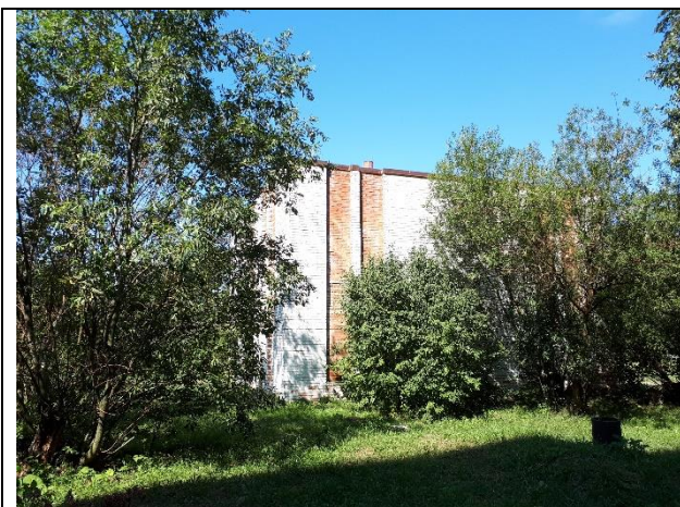
Фото 3. Оцениваемый объект недвижимости – здание насосной станции
