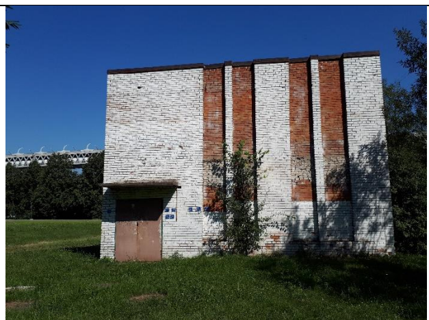
Фото 2. Оцениваемый объект недвижимости – здание насосной станции
