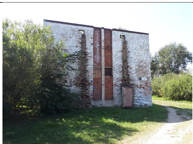
Фото 4. Оцениваемый объект недвижимости – здание насосной станции
