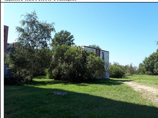
Фото 5. Оцениваемый объект недвижимости – здание насосной станции
