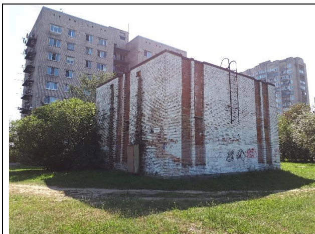
Фото 1. Оцениваемый объект недвижимости – здание насосной станции
