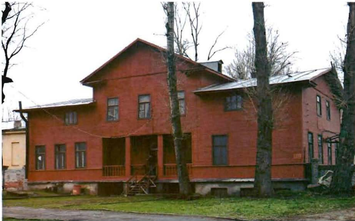
Фото №1. Южный фасад.
