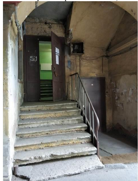
Фото 10. Общий вход с жилыми помещениями со двора
