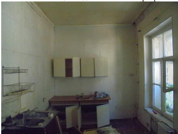
Фото 27. Общий вид и состояние квартиры
