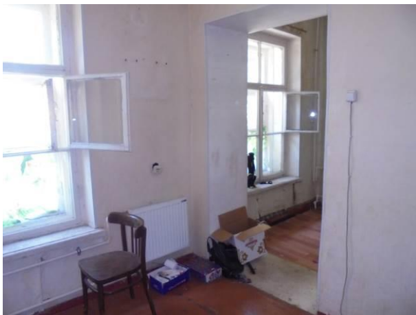
Фото 21. Общий вид и состояние квартиры
