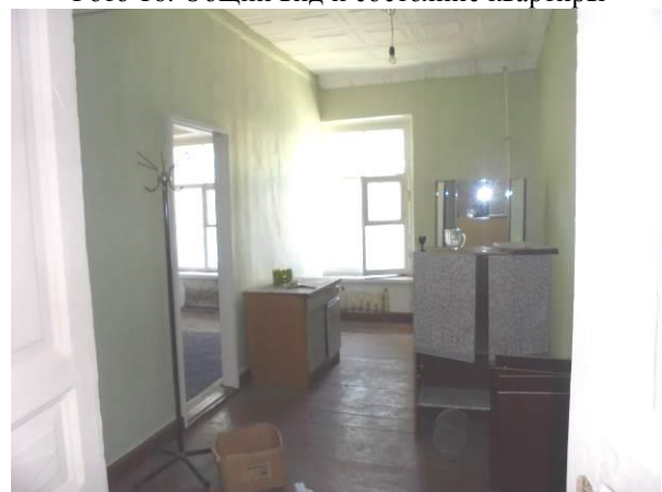
Фото 18. Общий вид и состояние квартиры
