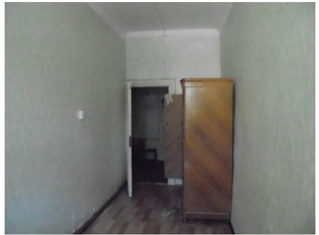
Фото 22. Общий вид и состояние квартиры
