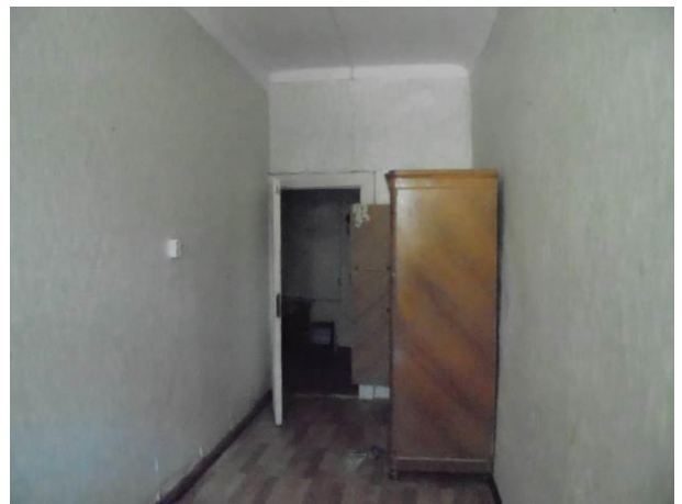
Фото 22. Общий вид и состояние квартиры
