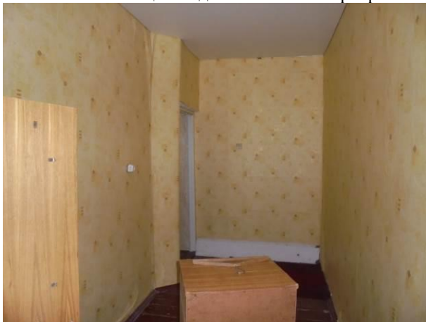
Фото 23. Общий вид и состояние квартиры
