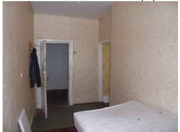
Фото 24. Общий вид и состояние квартиры
