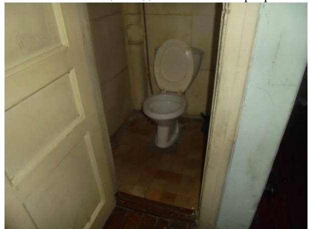
Фото 26. Общий вид и состояние квартиры
