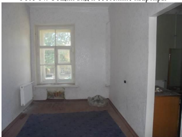
Фото 16. Общий вид и состояние квартиры
