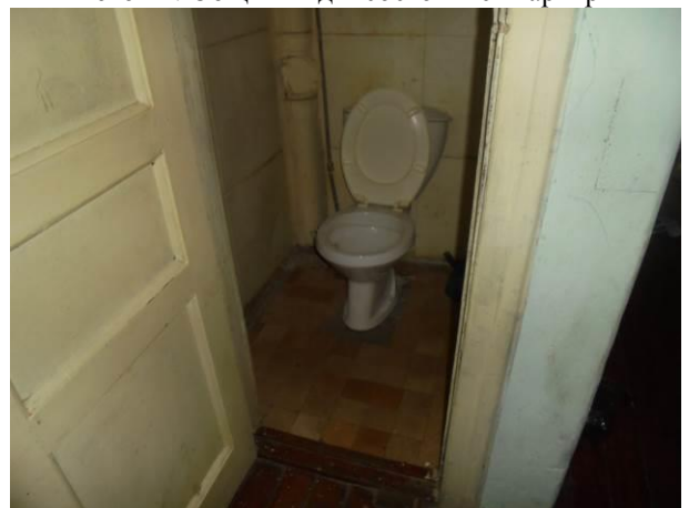
Фото 26. Общий вид и состояние квартиры
