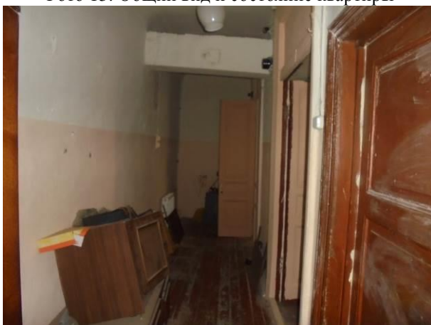
Фото 15. Общий вид и состояние квартиры
