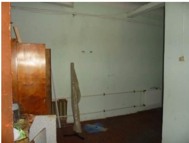
Фото 13. Общий вид и состояние квартиры
