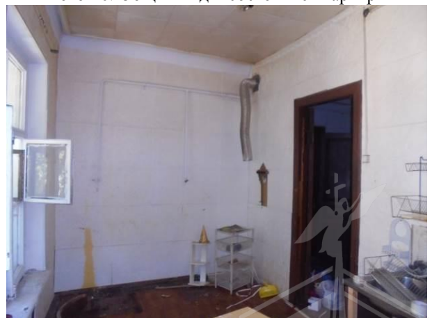
Фото 28. Общий вид и состояние квартиры
