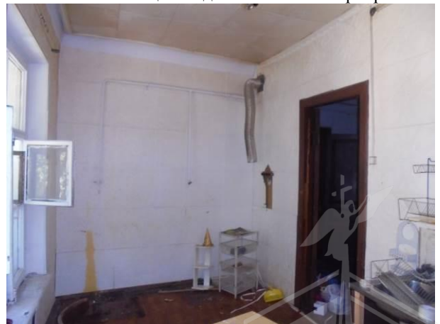
Фото 28. Общий вид и состояние квартиры
