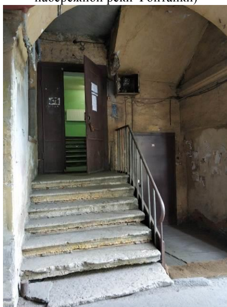
Фото 10. Общий вход с жилыми помещениями со двора
