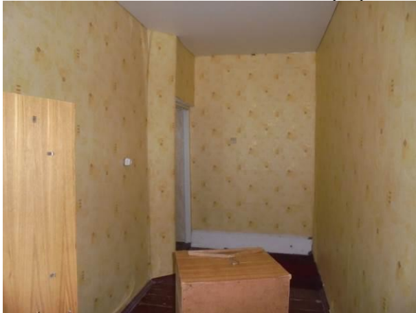
Фото 23. Общий вид и состояние квартиры
