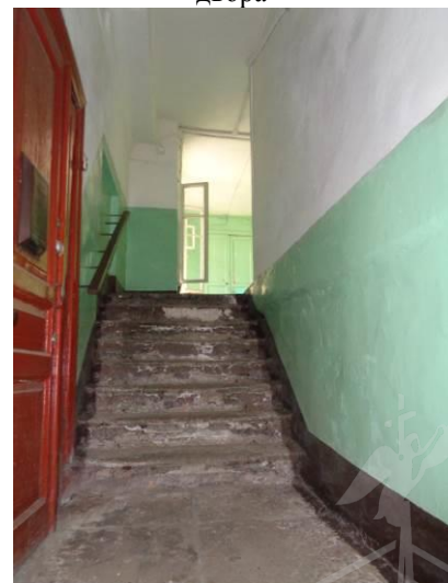
Фото 12. Общий вид и состояние помещений общего пользования (лестница)
