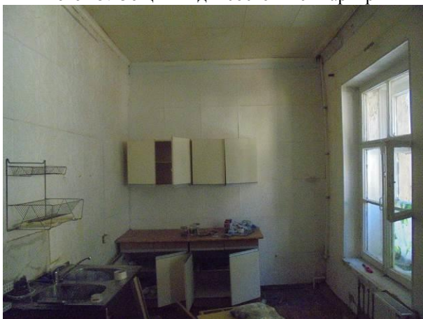
Фото 27. Общий вид и состояние квартиры
