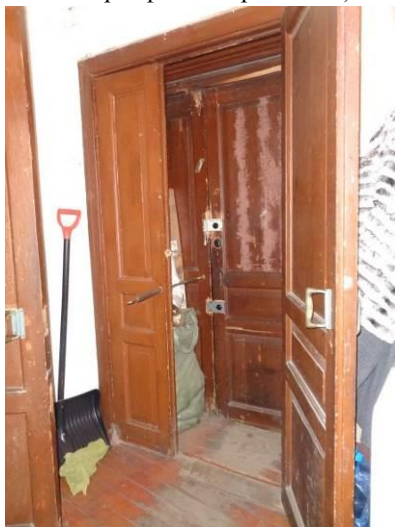
Фото 11. Общий вид и состояние помещений общего пользования (вход в квартиру)
