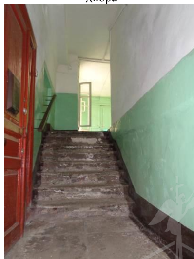
Фото 12. Общий вид и состояние помещений общего пользования (лестница)
