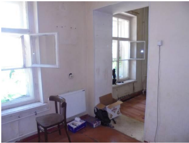
Фото 21. Общий вид и состояние квартиры
