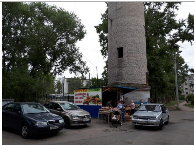
Фото 4. Оцениваемый объект недвижимости – здание водонапорной башни
