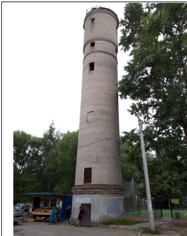
Фото 1. Оцениваемый объект недвижимости – здание водонапорной башни.
