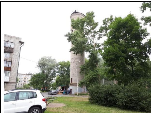
Фото 3. Оцениваемый объект недвижимости – здание водонапорной башни
