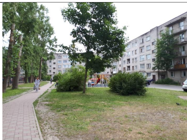
Фото 10. Ближайшее окружение. Жилая застройка (д. №№12, 14 пос. Шушары, Ленсоветовский)
