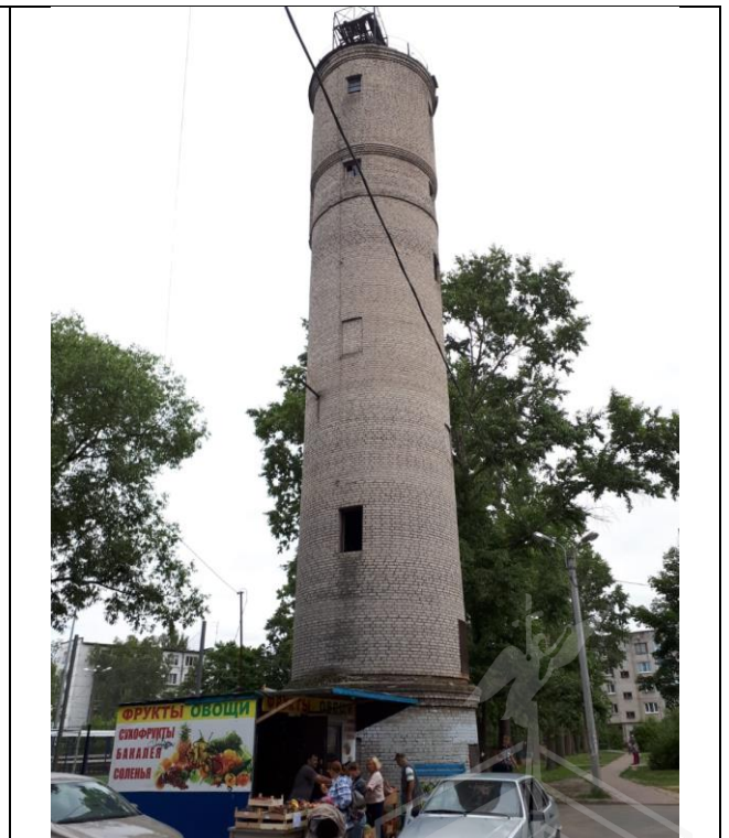
Фото 2. Оцениваемый объект недвижимости – здание водонапорной башни
