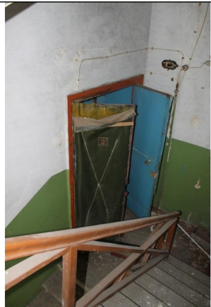
Фото 14 Вид входной двери и лестничной клетки
