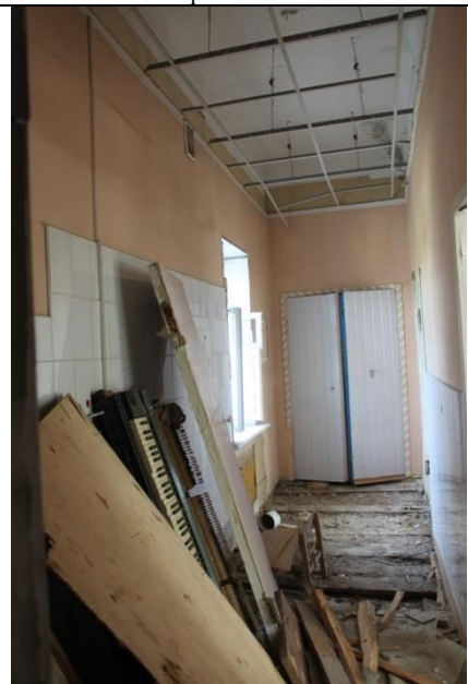
Фото 16 Вид части помещения №1 (кухня-коридор)
