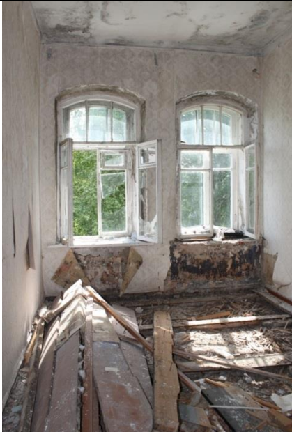
Вид части помещения №4
