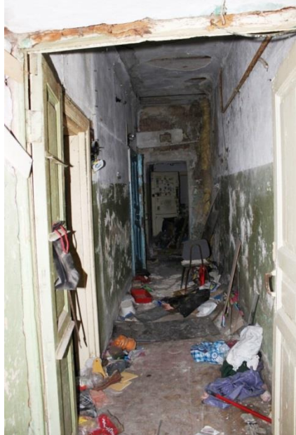
Фото 15 Вид части помещения №1 (коридор)
