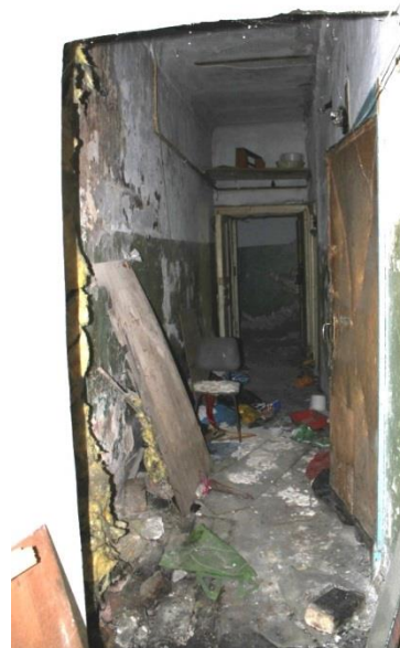
Фото 16 Вид части помещения №1 (коридор)
