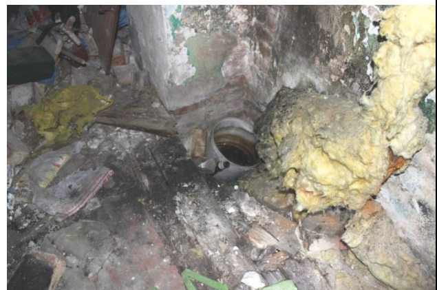
Фото 18 Вид части помещения №1
