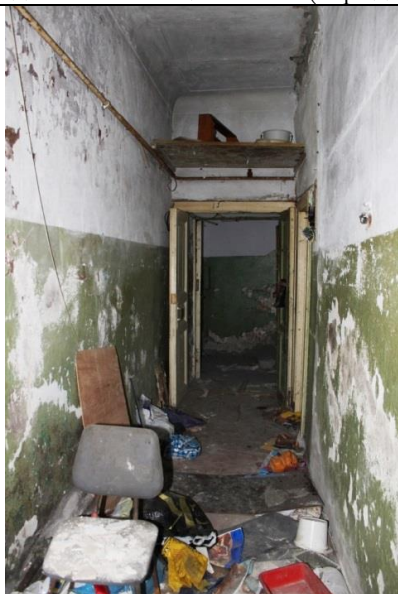
Фото 17 Вид части помещения №1 (коридор)
