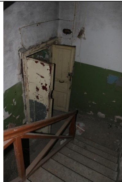
Фото 14 Вид входной двери
