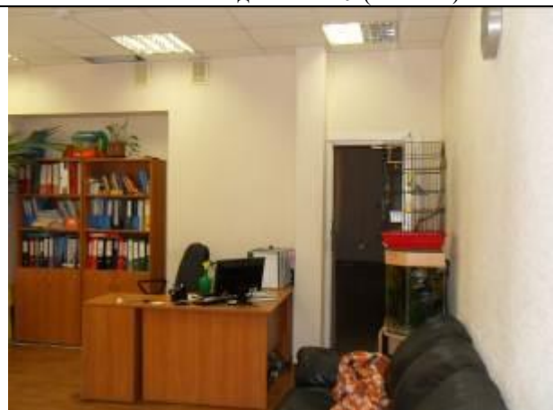
Фото 16 Состояние отделки ч.п. 5 (кабинет)
