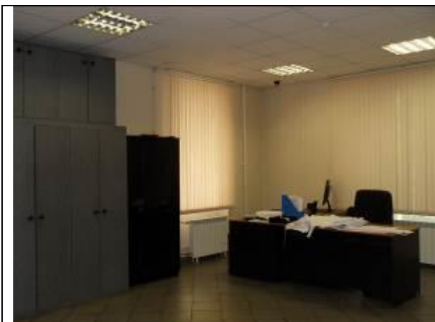
Фото 63 Состояние отделки ч.п. 9 (кабинет)
