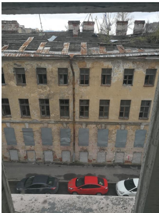
Фото 12. Вид из окна жилой комнаты ч.п 6.
