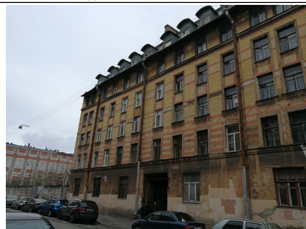
Фото 1. Вид части фасада жилого дома.
