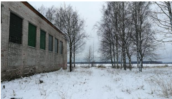
Фото 7. Окна, выходящие на улицу
