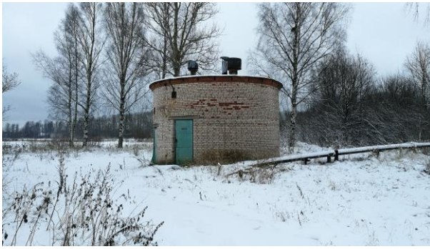
Фото 3. Вид фасада здания (лит. А2).
