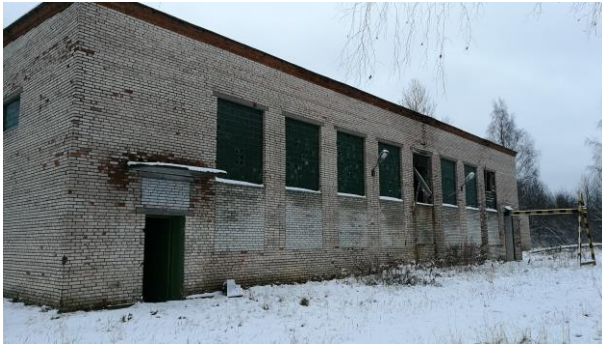
Фото 5. Окна, выходящие на улицу.
