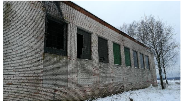
Фото 6. Окна, выходящие на улицу.
