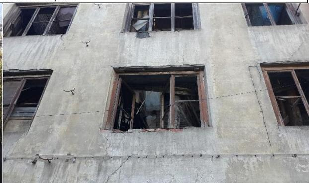
Фото 6. Дворовой фасад здания (в окна видно обрушение
