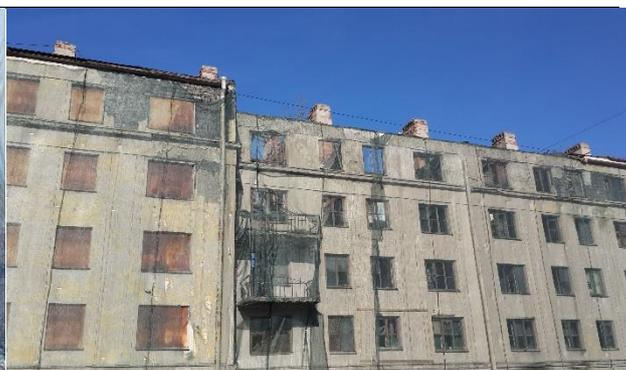
Фото 12. Уличный фасад здания, в котором расположен Объект оценки. Видно обрушение конструкций крыши и кровли
