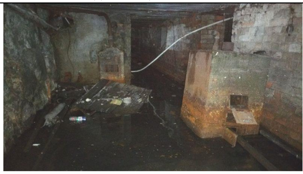
Фото 32 Вид помещений ч.п.4-н
