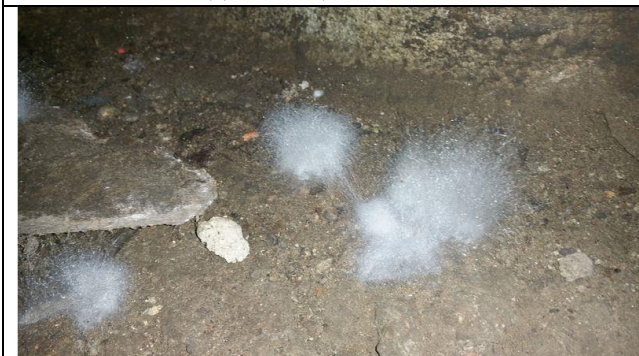
Фото 31 Вид помещений ч.п.4-н
