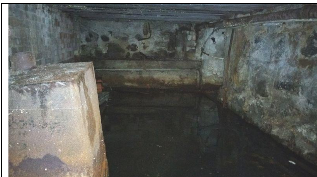
Фото 29 Вид помещений ч.п.4-н
