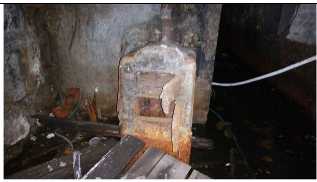
Фото 30 Вид помещений ч.п.4-н
