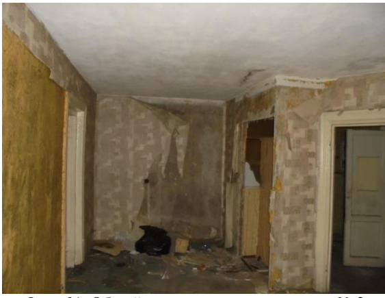
Фото 31. Общий вид и состояние квартиры № 2
