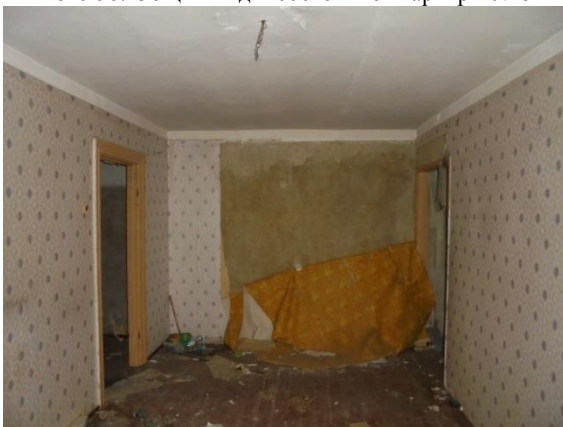
Фото 60. Общий вид и состояние квартиры № 5
