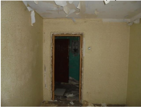
Фото 79. Общий вид и состояние квартиры № 7
