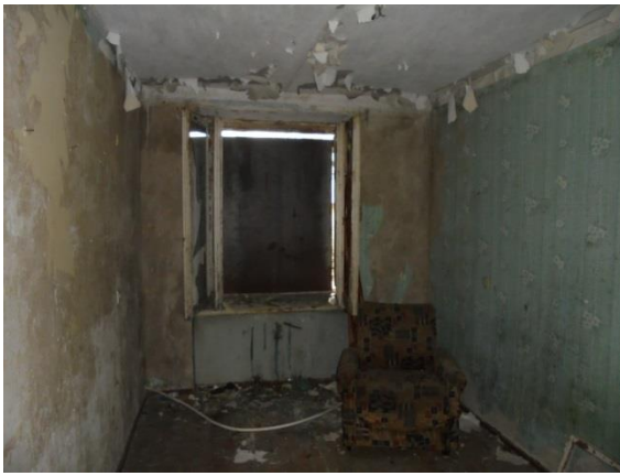
Фото 148. Общий вид и состояние квартиры № 14
