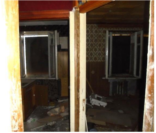
Фото 86. Общий вид и состояние квартиры № 8
