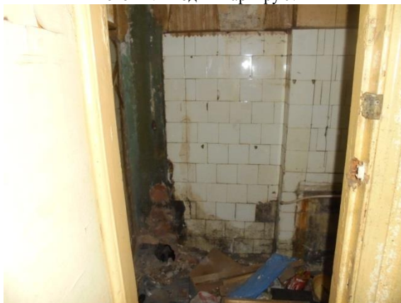
Фото 44. Общий вид и состояние квартиры № 4
