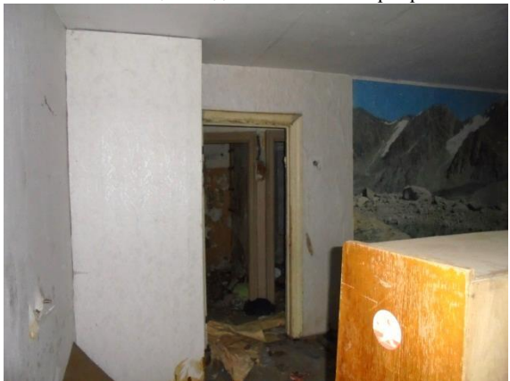
Фото 137. Общий вид и состояние квартиры № 12
