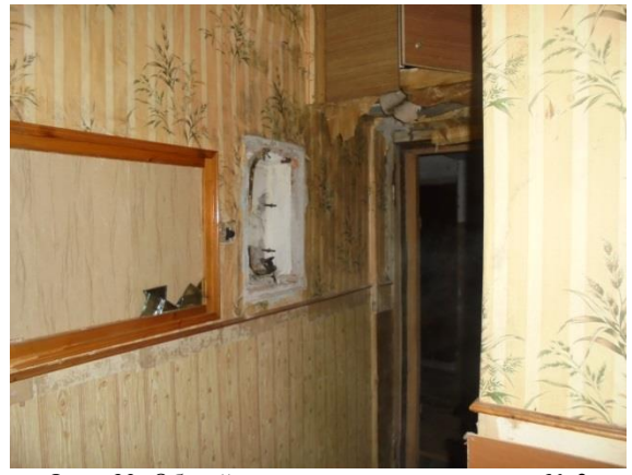
Фото 32. Общий вид и состояние квартиры № 2
