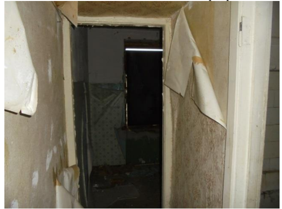
Фото 80. Общий вид и состояние квартиры № 7
