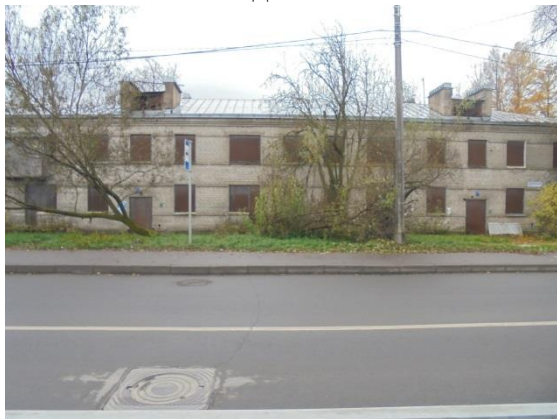
Фото 1. Вид на здание, в котором расположены объекты оценки (со стороны Межевой улицы)
