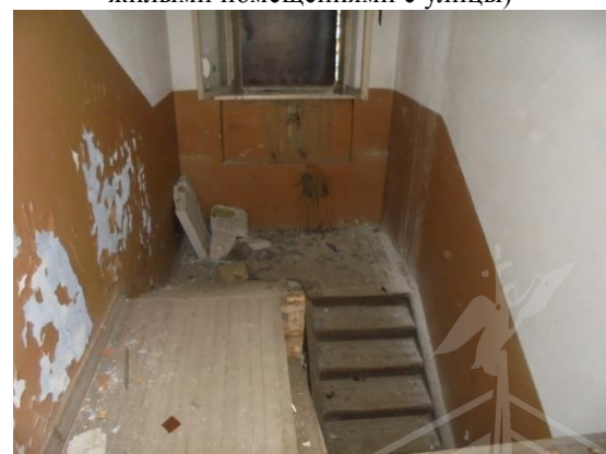
Фото 8. Общий вид и состояние помещений общего пользования (лестница на второй этаж)
