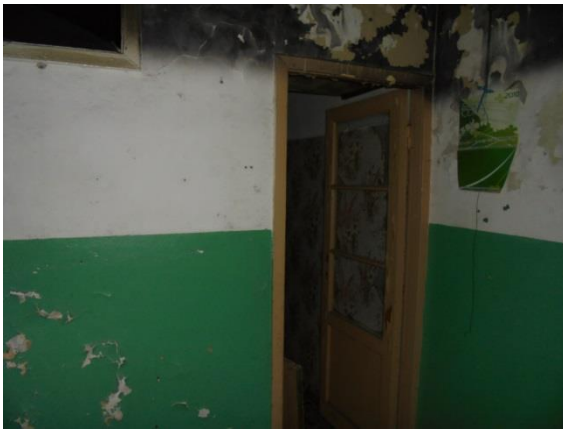
Фото 62. Общий вид и состояние квартиры № 5
