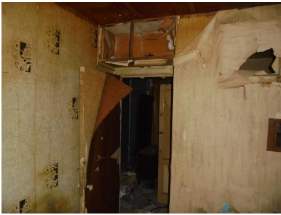
Фото 46. Общий вид и состояние квартиры № 4
