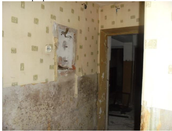
Фото 72. Общий вид и состояние квартиры № 6
