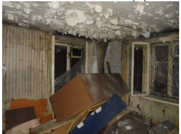
Фото 96. Общий вид и состояние квартиры № 9
