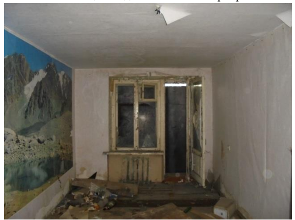
Фото 129. Общий вид и состояние квартиры № 12
