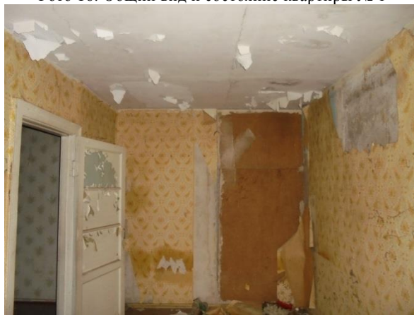
Фото 18. Общий вид и состояние квартиры № 1
