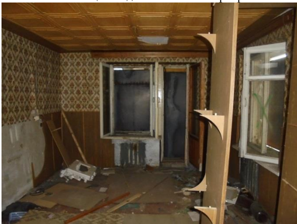
Фото 91. Общий вид и состояние квартиры № 8
