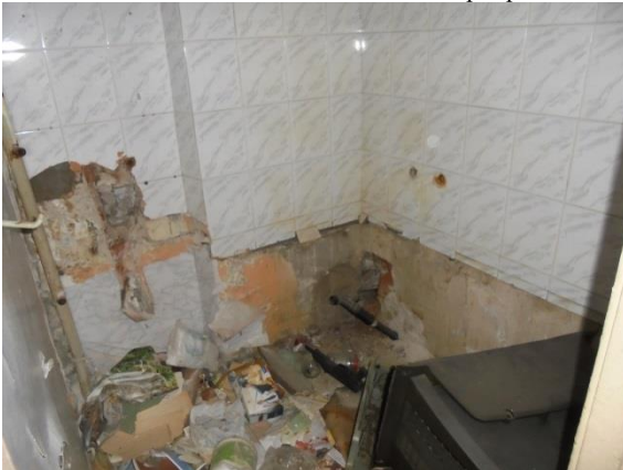
Фото 126. Общий вид и состояние квартиры № 12
