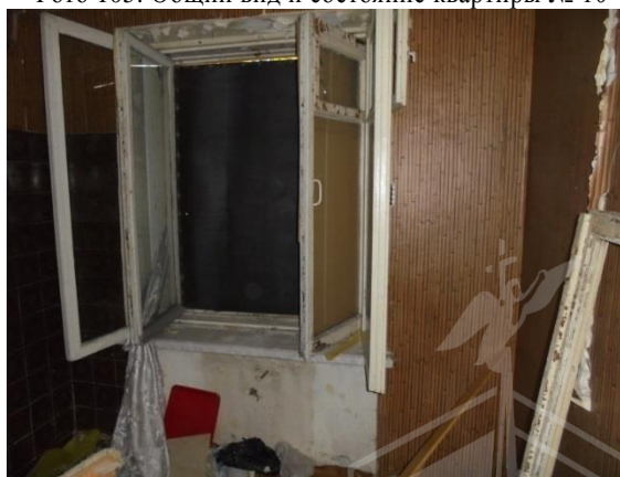
Фото 107. Общий вид и состояние квартиры № 10
