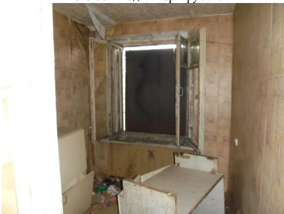
Фото 68. Общий вид и состояние квартиры № 6
