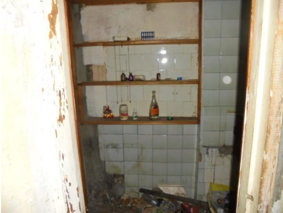
Фото 87. Общий вид и состояние квартиры № 8
