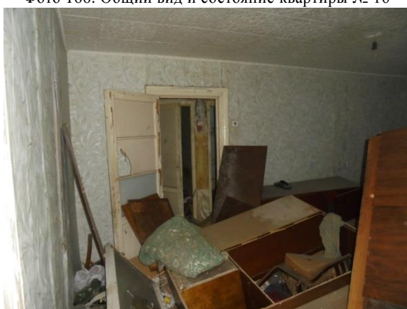
Фото 168. Общий вид и состояние квартиры № 16
