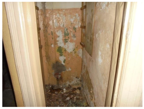
Фото 125. Общий вид и состояние квартиры № 12
