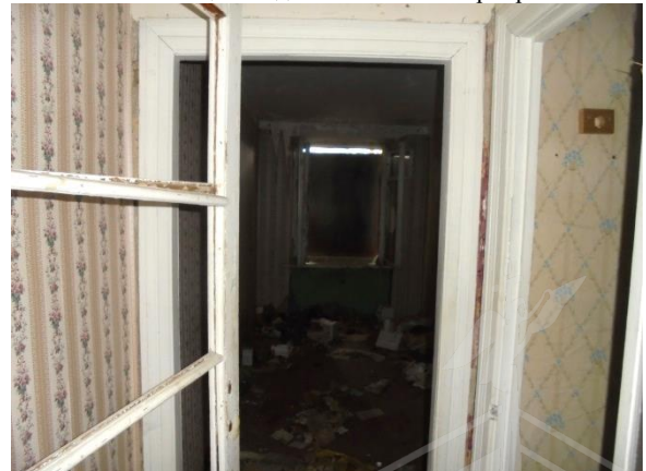
Фото 53. Общий вид и состояние квартиры № 5
