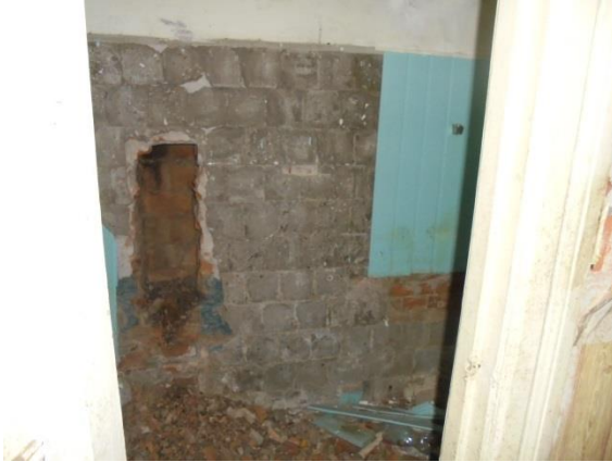
Фото 25. Общий вид и состояние квартиры № 2
