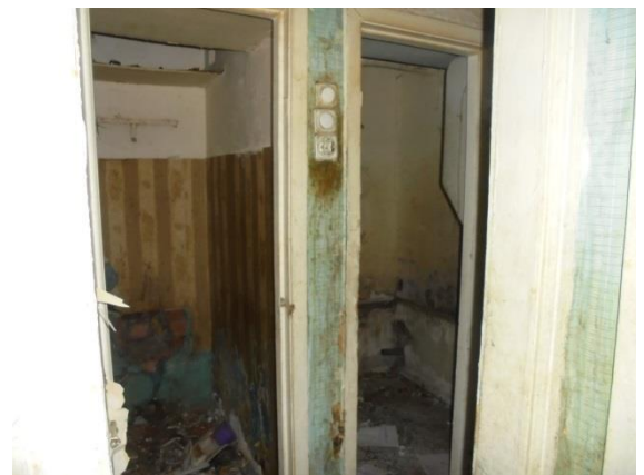
Фото 145. Общий вид и состояние квартиры № 14
