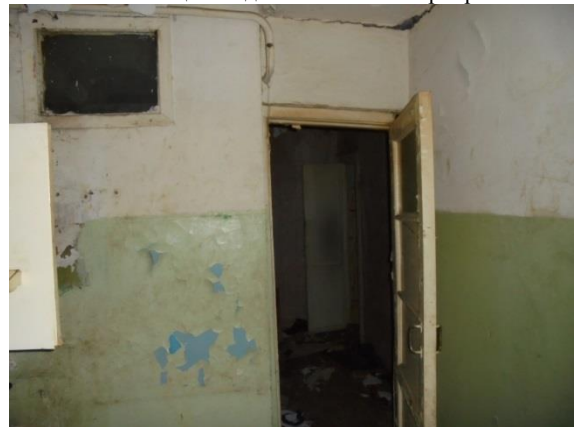
Фото 119. Общий вид и состояние квартиры № 11
