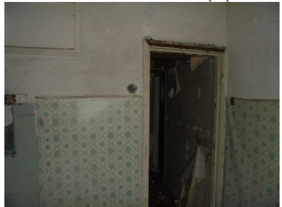
Фото 82. Общий вид и состояние квартиры № 7
