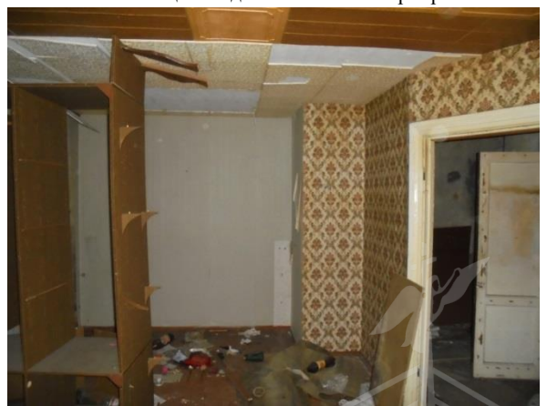
Фото 92. Общий вид и состояние квартиры № 8
