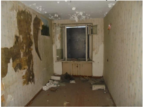
Фото 135. Общий вид и состояние квартиры № 12
