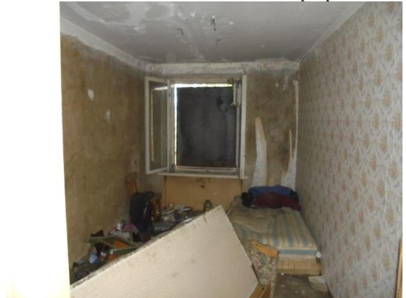
Фото 57. Общий вид и состояние квартиры № 5
