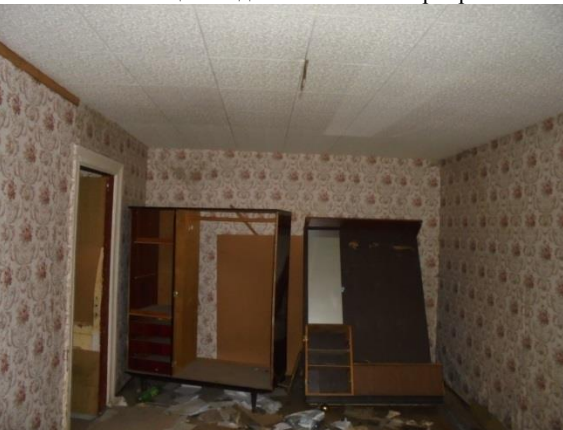
Фото 37. Общий вид и состояние квартиры № 3
