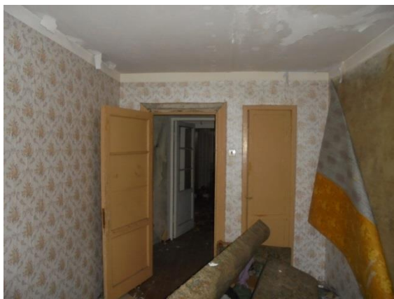
Фото 58. Общий вид и состояние квартиры № 5
