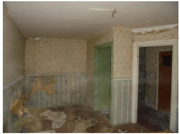
Фото 71. Общий вид и состояние квартиры № 6
