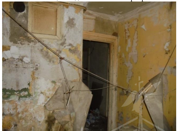
Фото 100. Общий вид и состояние квартиры № 9
