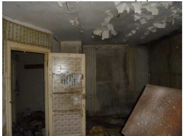
Фото 98. Общий вид и состояние квартиры № 9
