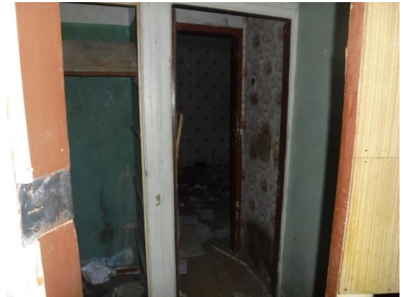
Фото 34. Общий вид и состояние квартиры № 3
