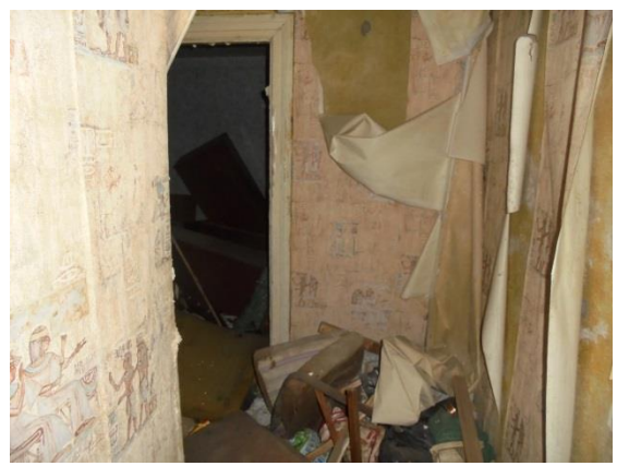
Фото 159. Общий вид и состояние квартиры № 16
