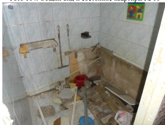
Фото 106. Общий вид и состояние квартиры № 10
