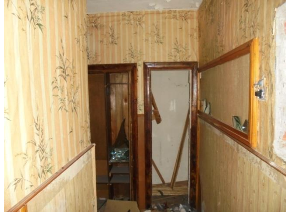
Фото 24. Общий вид и состояние квартиры № 2
