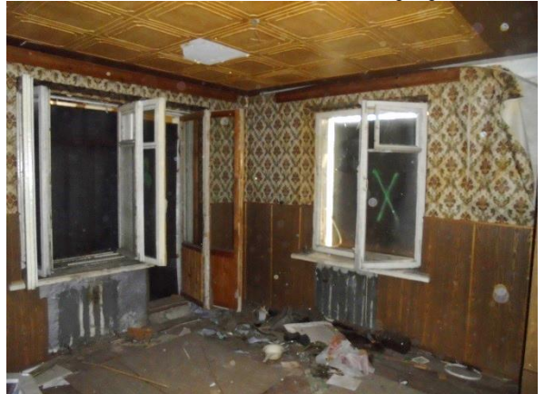
Фото 90. Общий вид и состояние квартиры № 8
