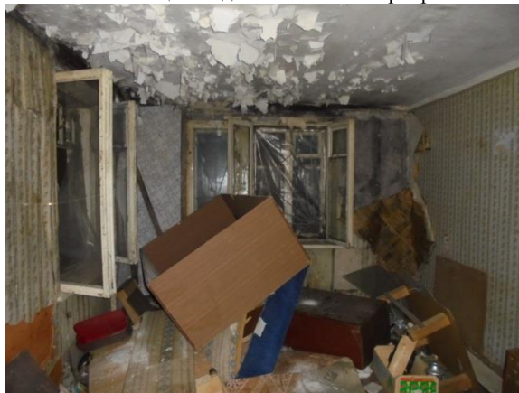
Фото 97. Общий вид и состояние квартиры № 9
