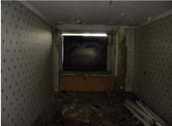
Фото 59. Общий вид и состояние квартиры № 5
