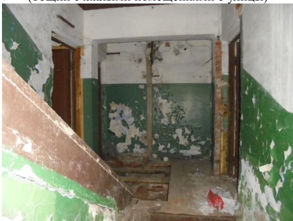
Фото 11. Общий вид и состояние помещений общего пользования (парадная дома)
