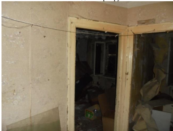
Фото 95. Общий вид и состояние квартиры № 9
