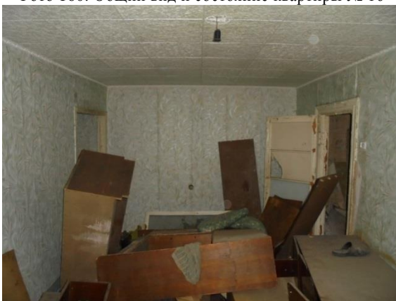
Фото 162. Общий вид и состояние квартиры № 16
