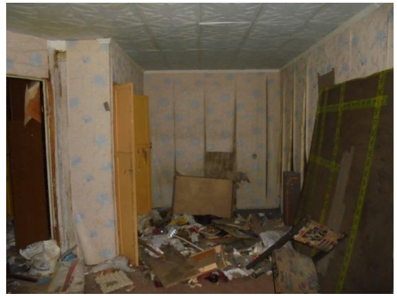
Фото 141. Общий вид и состояние квартиры № 13
