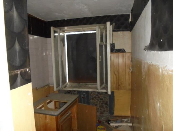
Фото 88. Общий вид и состояние квартиры № 8
