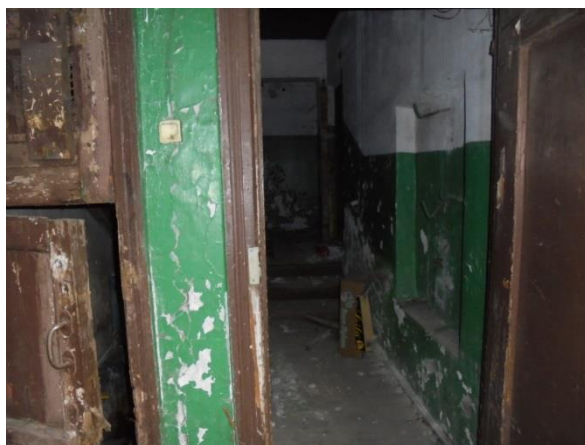
Фото 10. Общий вид и состояние помещений общего пользования (парадная дома)
