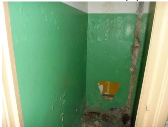
Фото 64. Общий вид и состояние квартиры № 5
