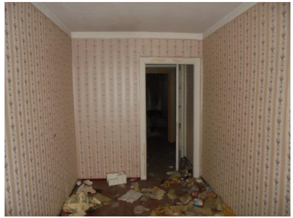
Фото 55. Общий вид и состояние квартиры № 5
