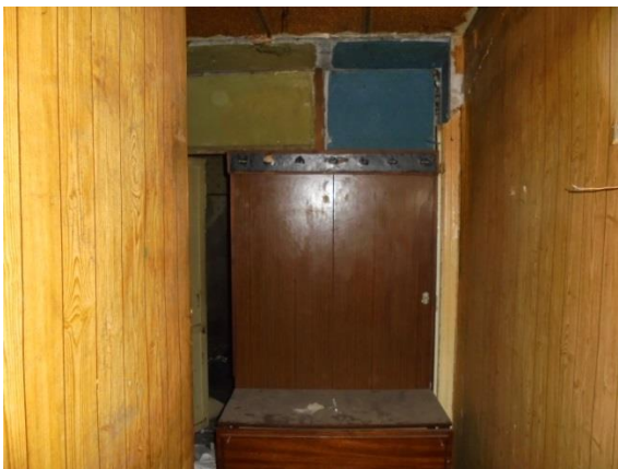
Фото 43. Общий вид и состояние квартиры № 4
