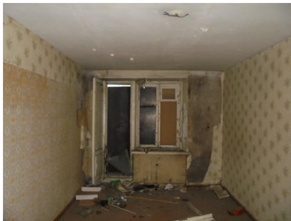
Фото 16. Общий вид и состояние квартиры № 1
