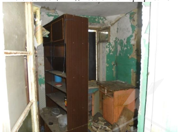
Фото 155. Общий вид и состояние квартиры № 15
