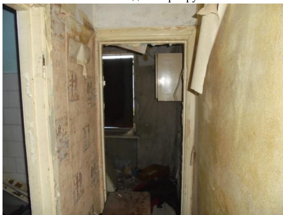
Фото 160. Общий вид и состояние квартиры № 16
