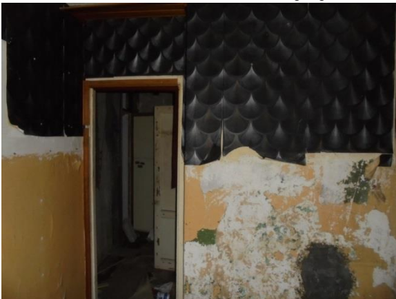
Фото 89. Общий вид и состояние квартиры № 8
