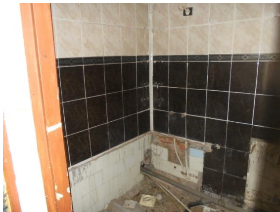
Фото 40. Общий вид и состояние квартиры № 3
