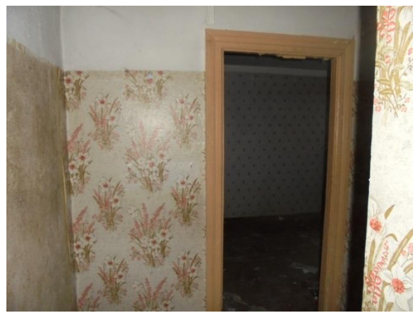
Фото 51. Общий вид и состояние квартиры № 5
