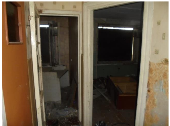
Фото 67. Общий вид и состояние квартиры № 6
