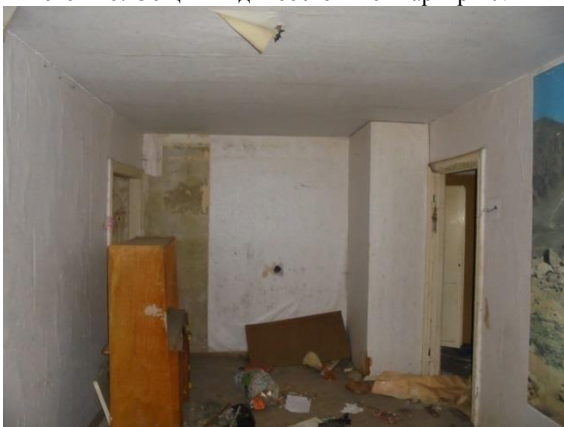
Фото 130. Общий вид и состояние квартиры № 12
