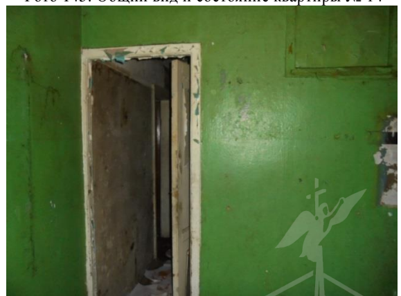
Фото 147. Общий вид и состояние квартиры № 14
