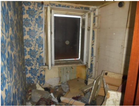
Фото 142. Общий вид и состояние квартиры № 13
