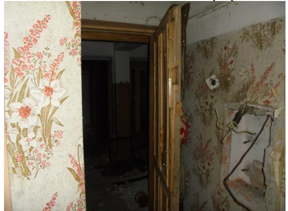
Фото 65. Общий вид и состояние квартиры № 5
