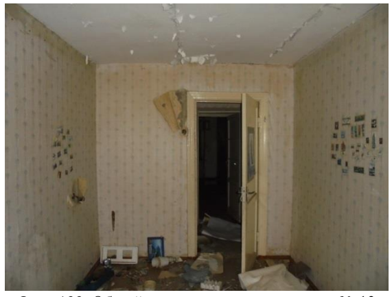
Фото 133. Общий вид и состояние квартиры № 12
