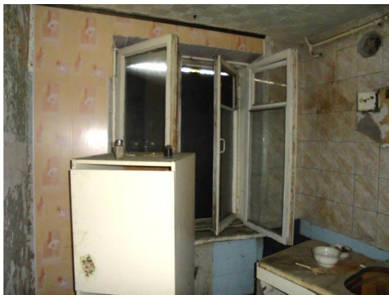
Фото 39. Общий вид и состояние квартиры № 3
