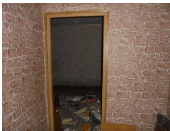
Фото 103. Общий вид и состояние квартиры № 10
