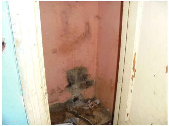
Фото 157. Общий вид и состояние квартиры № 15
