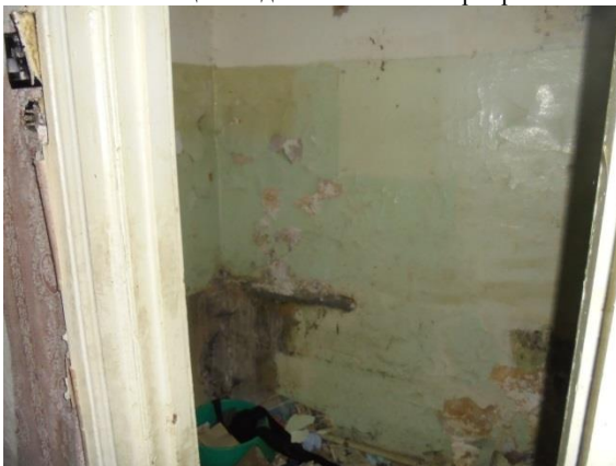
Фото 120. Общий вид и состояние квартиры № 11
