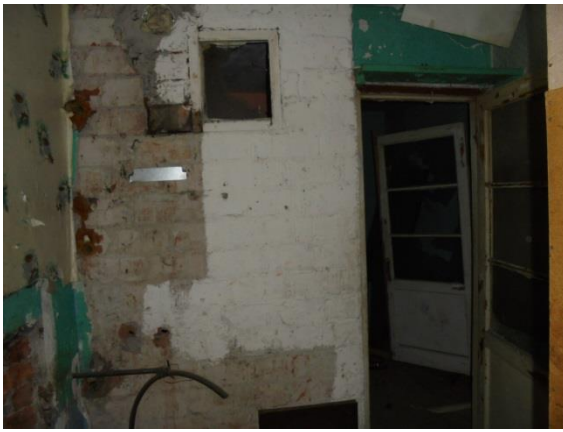
Фото 156. Общий вид и состояние квартиры № 15
