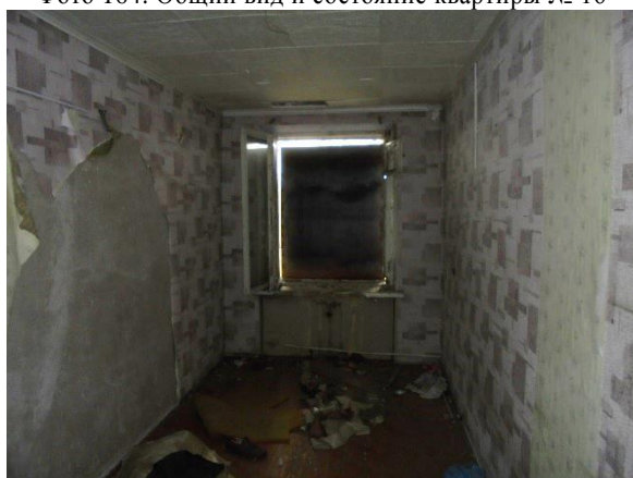
Фото 166. Общий вид и состояние квартиры № 16
