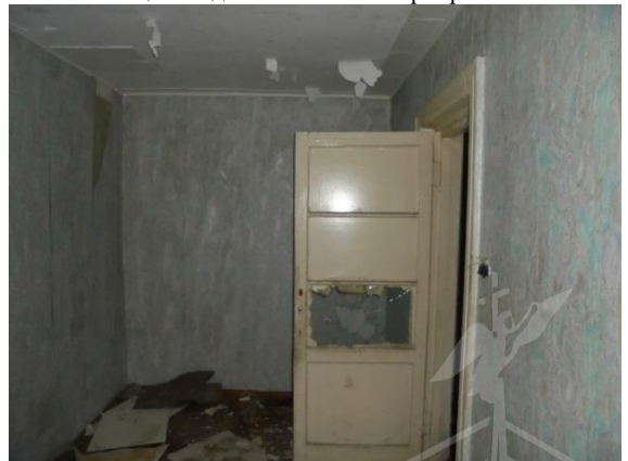
Фото 30. Общий вид и состояние квартиры № 2
