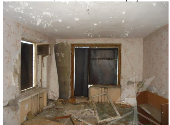
Фото 76. Общий вид и состояние квартиры № 7
