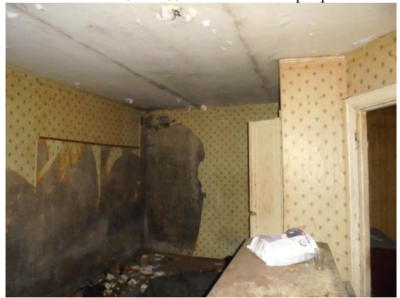
Фото 49. Общий вид и состояние квартиры № 4
