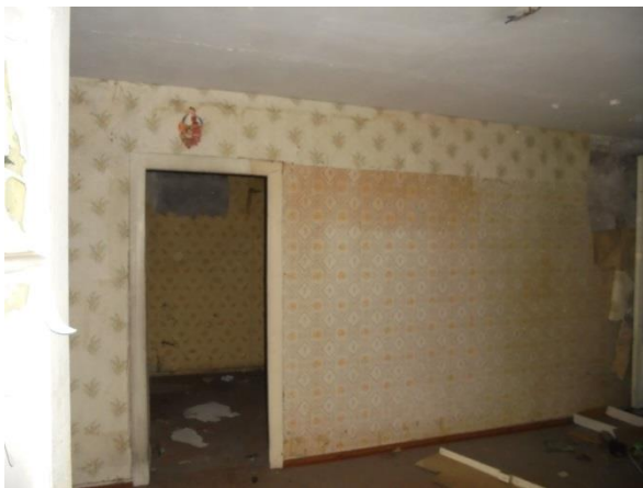
Фото 15. Общий вид и состояние квартиры № 1
