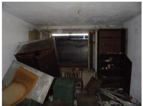
Фото 153. Общий вид и состояние квартиры № 15
