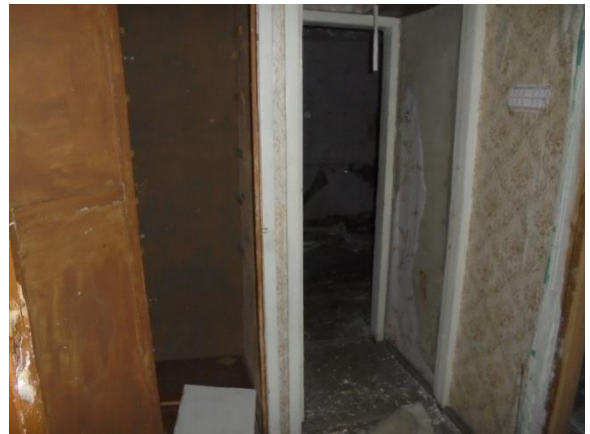
Фото 74. Общий вид и состояние квартиры № 7
