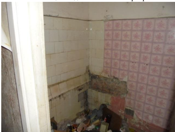
Фото 83. Общий вид и состояние квартиры № 7
