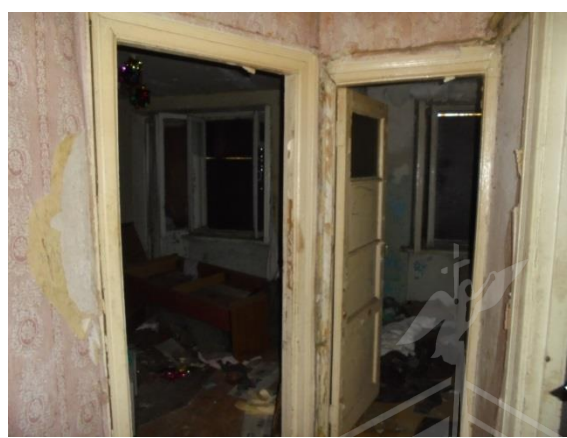
Фото 115. Общий вид и состояние квартиры № 11
