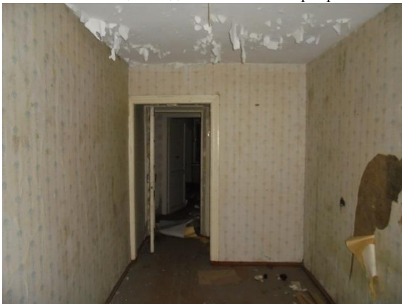
Фото 136. Общий вид и состояние квартиры № 12
