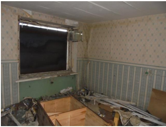
Фото 70. Общий вид и состояние квартиры № 6
