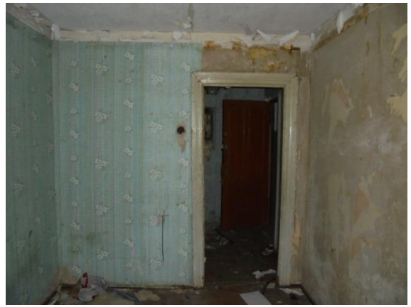
Фото 149. Общий вид и состояние квартиры № 14
