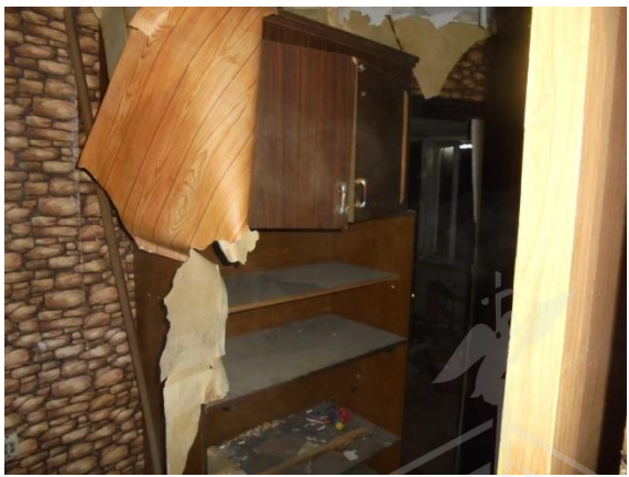
Фото 139. Общий вид и состояние квартиры № 13
