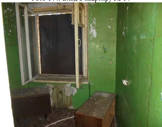
Фото 146. Общий вид и состояние квартиры № 14
