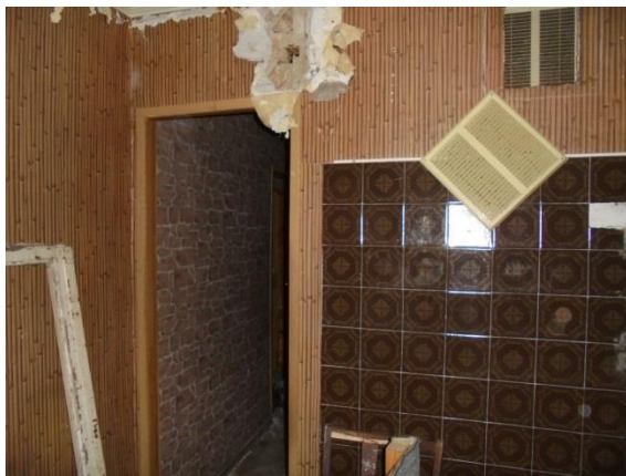
Фото 108. Общий вид и состояние квартиры № 10
