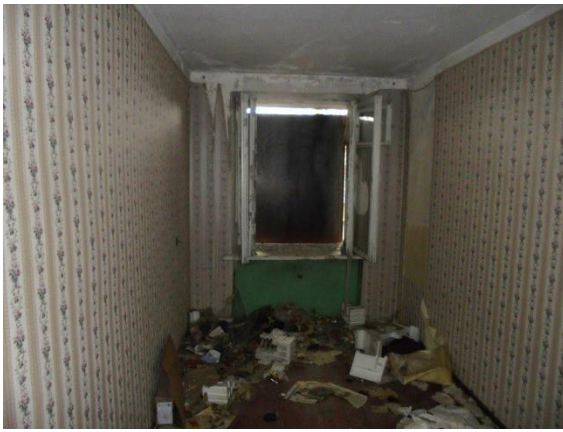
Фото 54. Общий вид и состояние квартиры № 5
