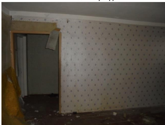
Фото 52. Общий вид и состояние квартиры № 5
