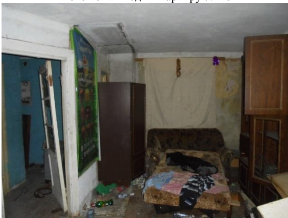
Фото 154. Общий вид и состояние квартиры № 15
