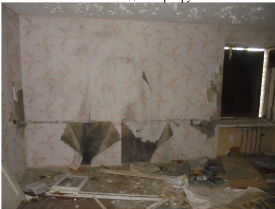
Фото 75. Общий вид и состояние квартиры № 7
