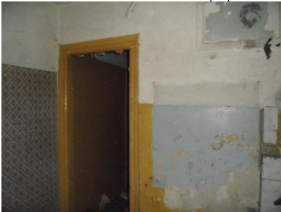
Фото 128. Общий вид и состояние квартиры № 12
