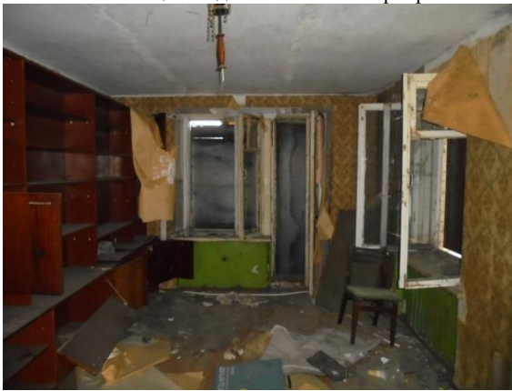
Фото 150. Общий вид и состояние квартиры № 14
