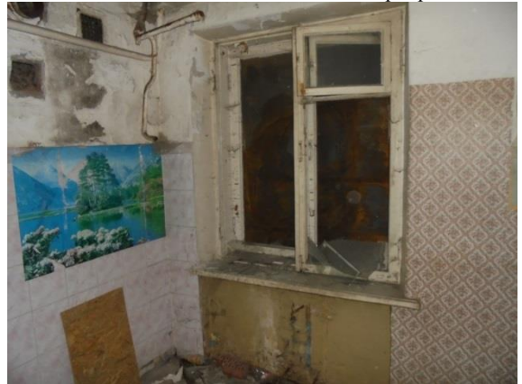
Фото 127. Общий вид и состояние квартиры № 12
