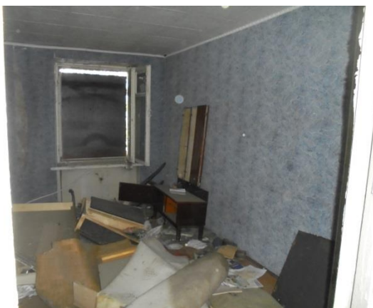
Фото 164. Общий вид и состояние квартиры № 16
