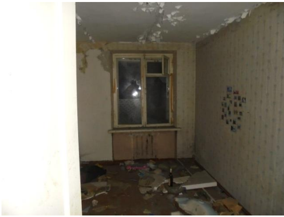
Фото 132. Общий вид и состояние квартиры № 12
