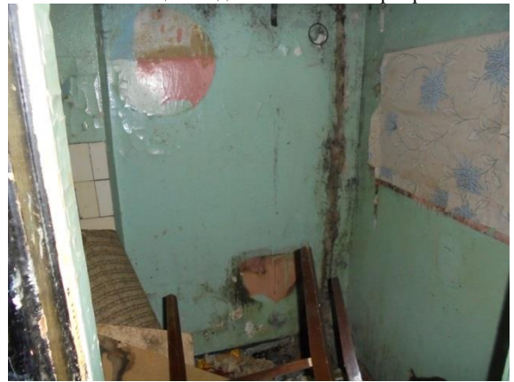
Фото 143. Общий вид и состояние квартиры № 13
