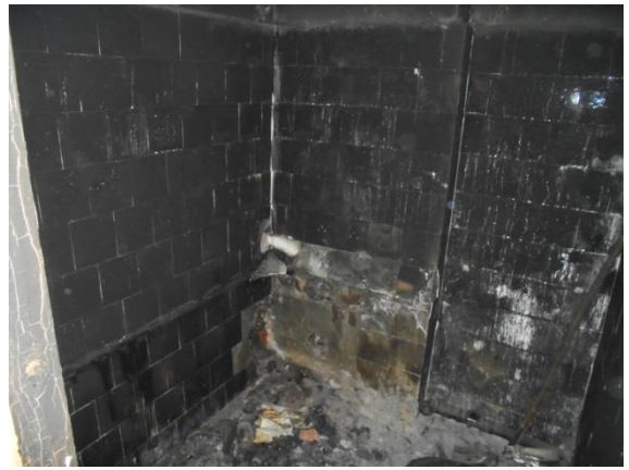
Фото 63. Общий вид и состояние квартиры № 5
