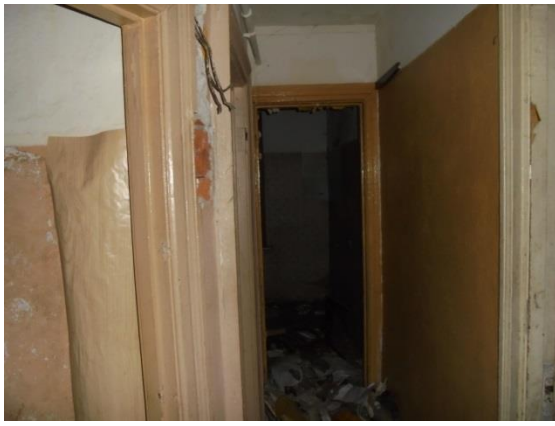
Фото 124. Общий вид и состояние квартиры № 12
