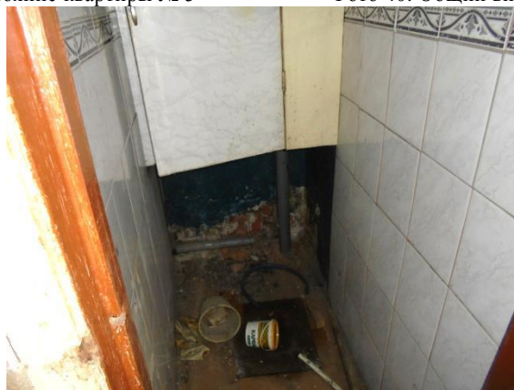
Фото 41. Общий вид и состояние квартиры № 3
