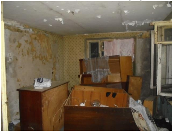
Фото 48. Общий вид и состояние квартиры № 4
