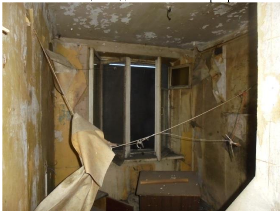
Фото 99. Общий вид и состояние квартиры № 9
