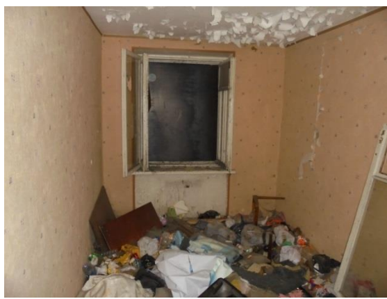
Фото 109. Общий вид и состояние квартиры № 10
