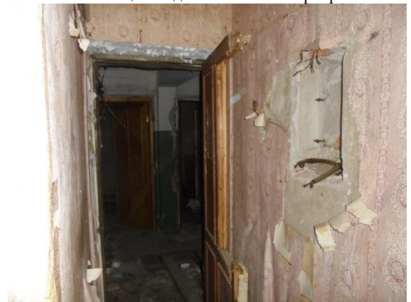
Фото 121. Общий вид и состояние квартиры № 11
