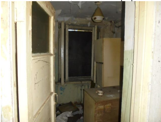
Фото 118. Общий вид и состояние квартиры № 11
