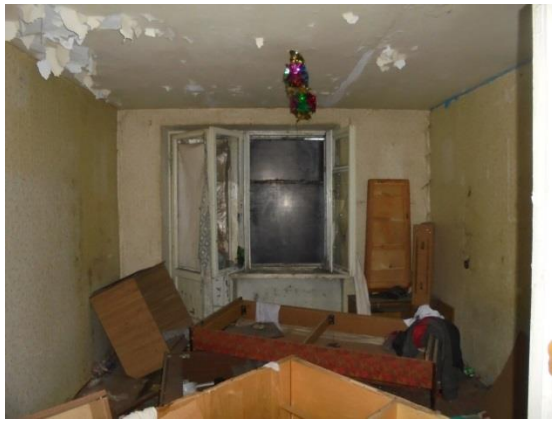
Фото 116. Общий вид и состояние квартиры № 11
