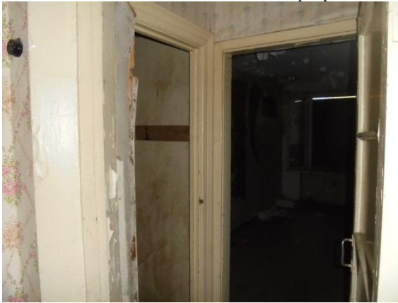
Фото 134. Общий вид и состояние квартиры № 12
