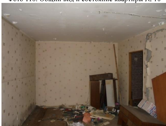
Фото 112. Общий вид и состояние квартиры № 10
