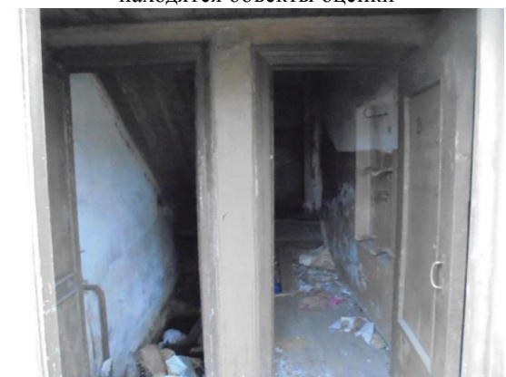
Фото 7. Общий вид и состояние помещений общего пользования (вход в парадную дома)
