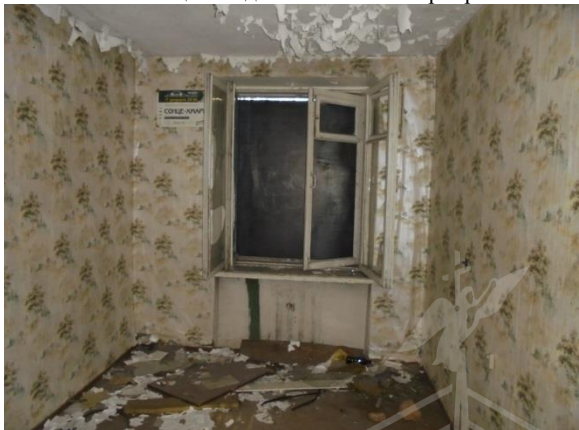
Фото 38. Общий вид и состояние квартиры № 3
