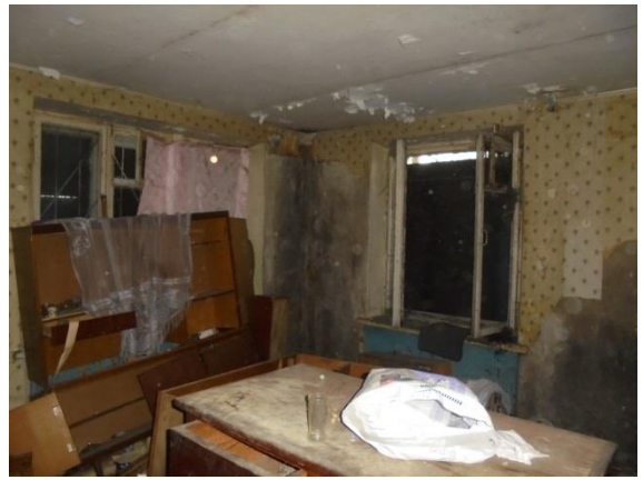
Фото 47. Общий вид и состояние квартиры № 4
