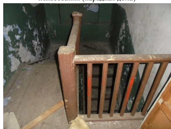
Фото 12. Общий вид и состояние помещений общего пользования (лестница на второй этаж)
