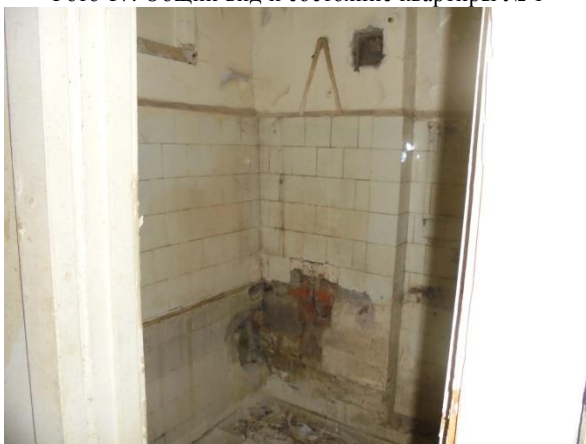
Фото 19. Общий вид и состояние квартиры № 1
