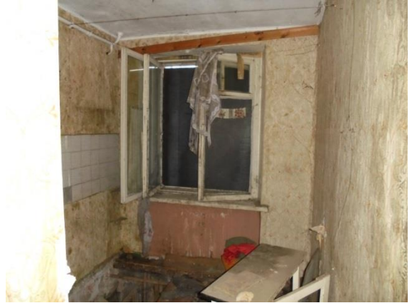
Фото 26. Общий вид и состояние квартиры № 2
