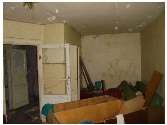
Фото 117. Общий вид и состояние квартиры № 11
