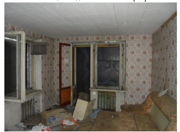
Фото 36. Общий вид и состояние квартиры № 3
