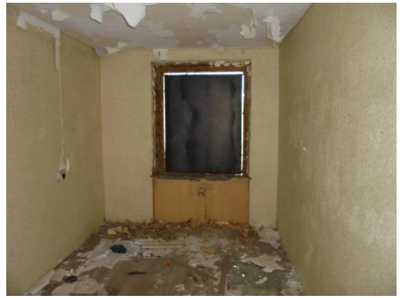
Фото 78. Общий вид и состояние квартиры № 7
