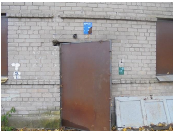
Фото 9. Вид входа в Объекты оценки №№9-16 (общий с жилыми помещениями с улицы)
