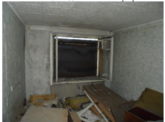
Фото 161. Общий вид и состояние квартиры № 16
