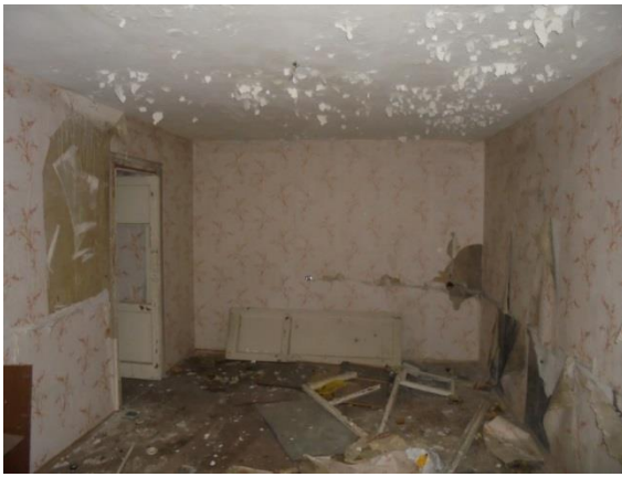
Фото 77. Общий вид и состояние квартиры № 7
