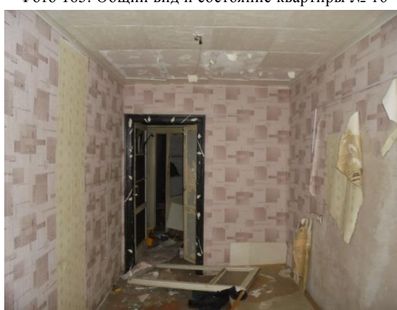
Фото 167. Общий вид и состояние квартиры № 16
