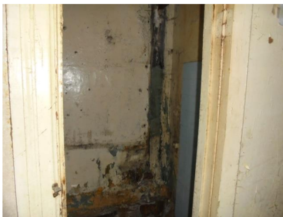
Фото 101. Общий вид и состояние квартиры № 9
