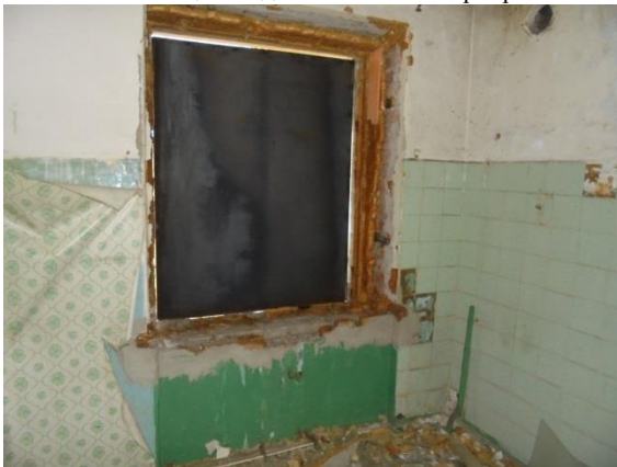
Фото 81. Общий вид и состояние квартиры № 7
