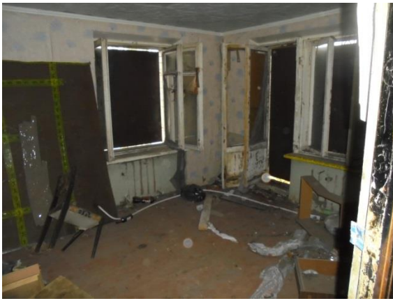
Фото 140. Общий вид и состояние квартиры № 13
