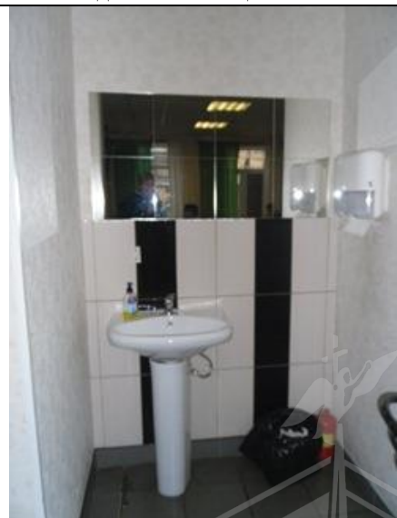
Фото 30 Вид части помещения №6
